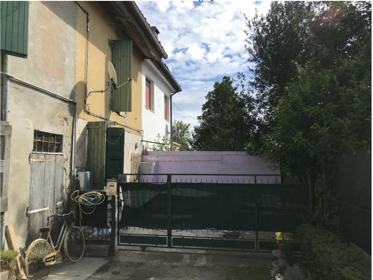
Il cancello di ingresso del fabbricato
