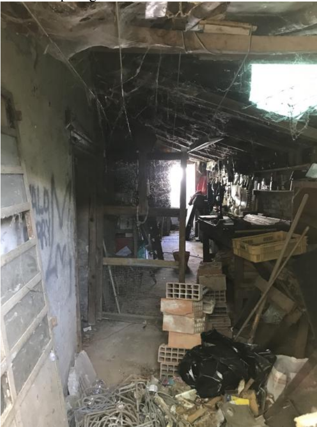
La zona ripostiglio e zona bagno lavanderia
