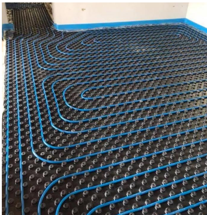
RISCALDAMENTO A PAVIMENTO
