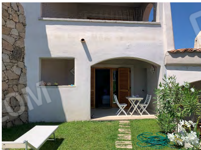
FOTO VERANDA PIANO TERRA
