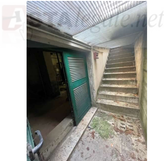
F43: piano seminterrato – scala esterna di servizio al locale tecnico
