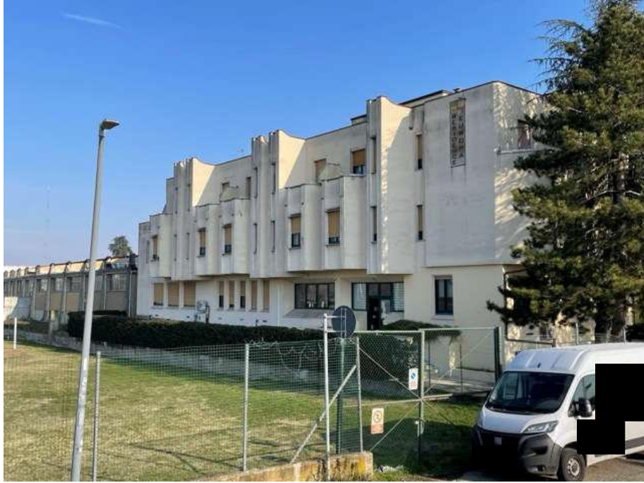
F2: Vista lato ovest (da Via Vaciago)
