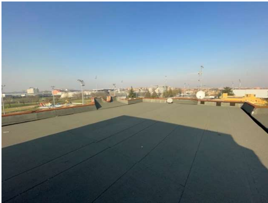
F40: terrazzo di copertura 3° piano attività ricettiva
