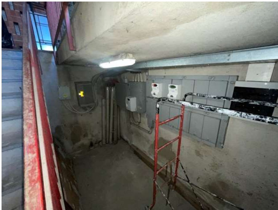
F44: piano seminterrato – scala esterna/locale contatori
