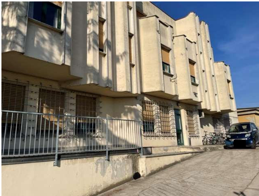
F4: Vista da cortile interno lato est
