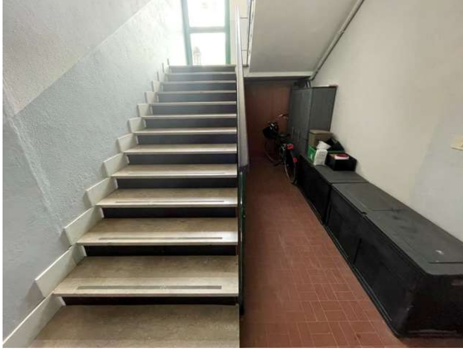
F42: piano seminterrato – scala comune
