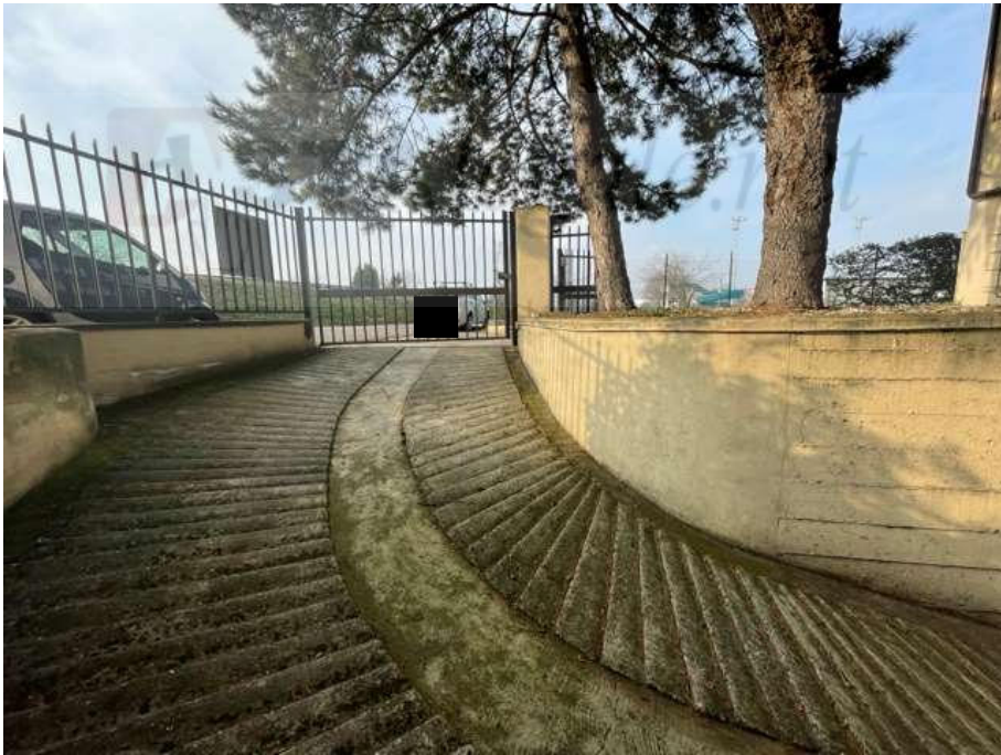
F6: Ingresso carrabile a servizio del piano seminterrato
