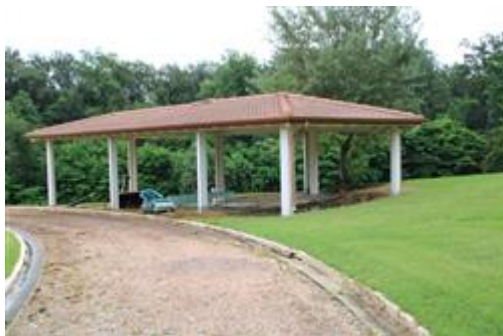
Foto 5: Porticato in cemento armato
