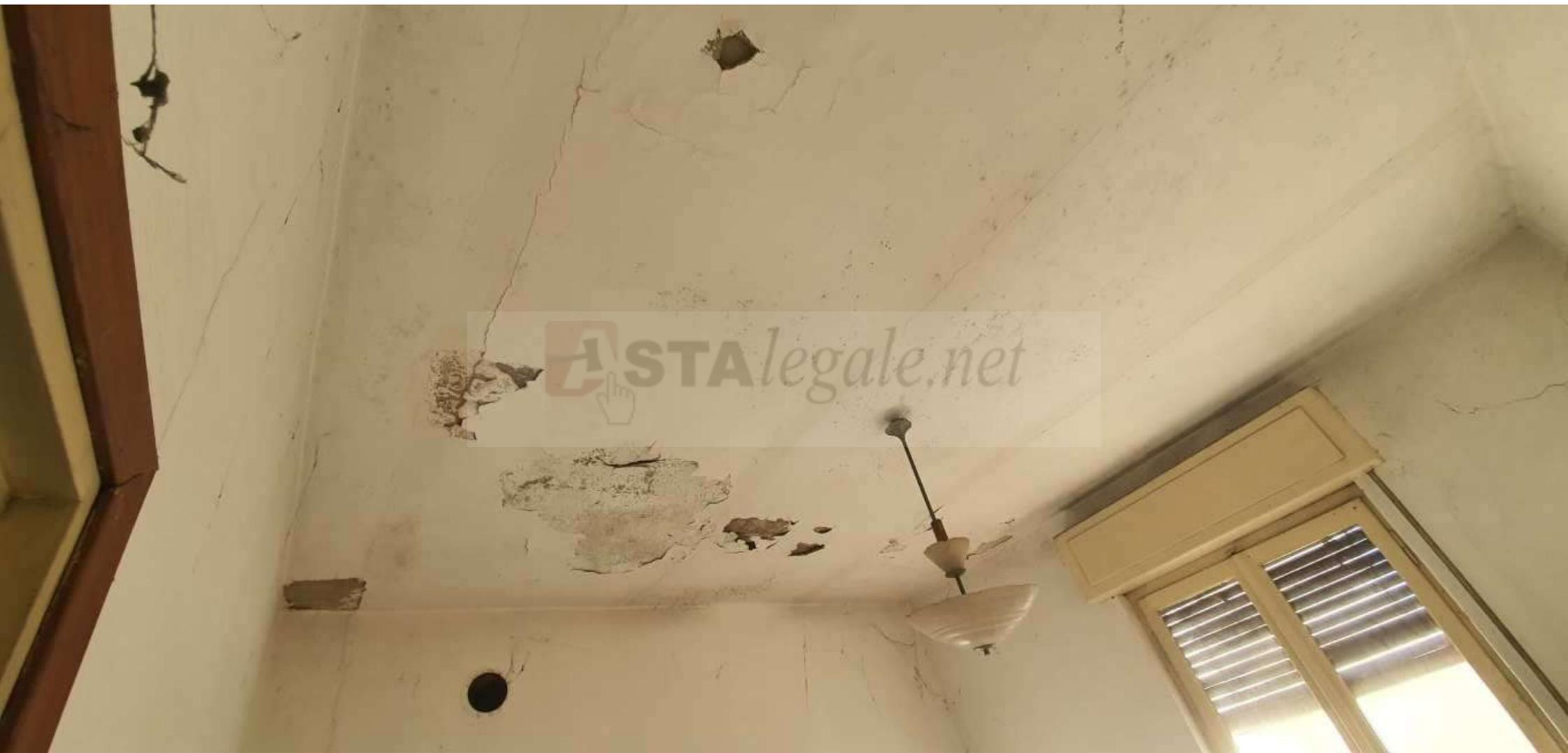
DISTACCHI DI INTONACO ED INFILTRAZIONI PLAFONE PIANO PRIMO
