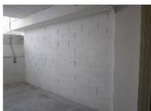
Per le divisioni dei garage, muratura interna divisoria tagliafuoco realizzata con elementi in argilla espansa tipo Lecablocco Tramezza Lecalite spessore cm ... (8, 10 o 12) non intonacata e tinteggiata bianca.
