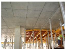
Realizzazione di solai piani in soletta piena di adeguato spessore, mediante il getto di calcestruzzo armato con barre incrociate o pannelli di rete elettrosaldata la distribuzione dei carichi e comunque secondo il disegno tecnico e calcoli statici. Spessore minimo cm 24. Al di sotto della soletta, per i poggioli e i garage verrà inserita una lastra di polistirene espanso (EPS) di spessore adeguato atto ad isolare e impedire il ponte termico verso l'interno della soletta.
