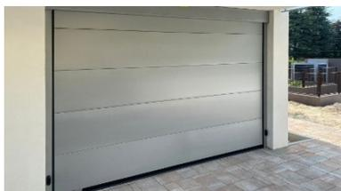
Fornitura e posa in opera di portoni sezionali per i garage, motorizzati, di colore bianco tipo Onda di produzione Ballan o altra ditta similare di primaria importanza, completo di maniglia di sollevamento, paracadute, coprifili esterni, motorizzazione con kit base esterno con sblocco monoforo ( se garage privi di porta d 'accesso interna), sensore di sforzo, trasmettitore e ricevitore con antenna integrata, montaggio messa in funzione e collaudo.
