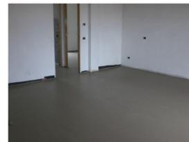
Realizzazione di massetto di sottofondo di adeguato spessore atto alla posa dei pavimenti in ceramica o in legno, (realizzato sopra i massetti alleggeriti e i pannelli dell'impianto di riscaldamento a pavimento), costituito da una miscela di sabbia e cemento, opportunamente dosati ed impastati con additivo, con superficie superiore tirata a frattazzo, idoneo alla posa in opera di pavimenti da incollare; compresa
