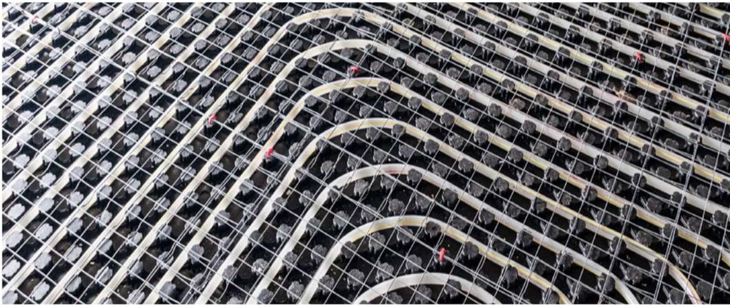
Il raffrescamento estivo è garantito dall' utilizzo delle medesime tubature del riscaldamento a pavimento. Così come avviene in fase di riscaldamento, anche il fresco viene distribuito agli ambienti mediante irraggiamento.
