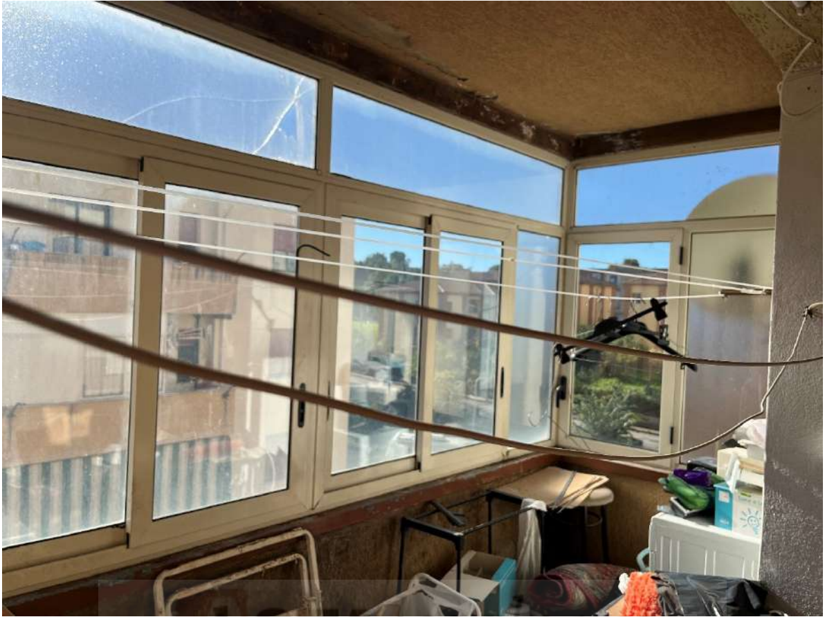
(balcone con veranda lato sud dell'appartamento)
