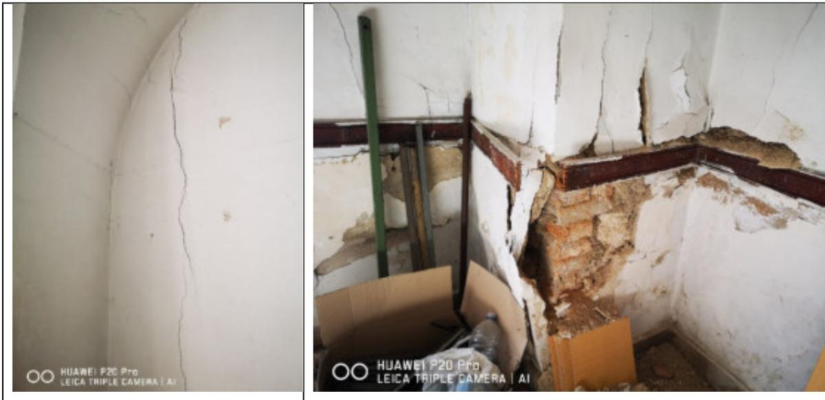
**Foto n.20: Deposito – sub. 4 – Lesioni e distacchi intonaco**
