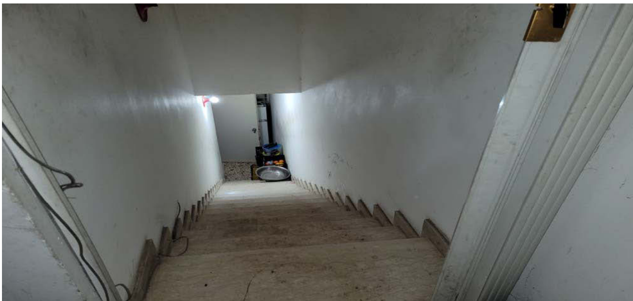
Fg 73 p.Ila 2685 sub. 2 (piano terzo)
