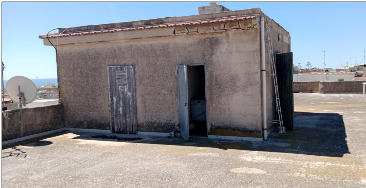
Foto 13 Torrino vano scala
