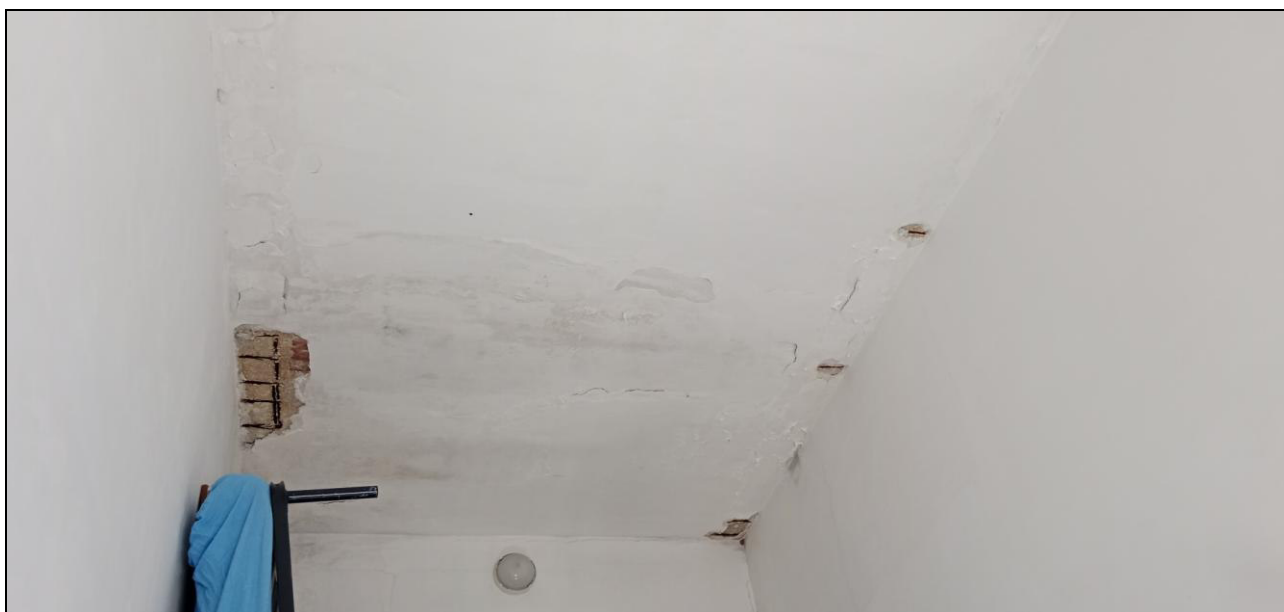
Foto 12 Torrino vano scala
