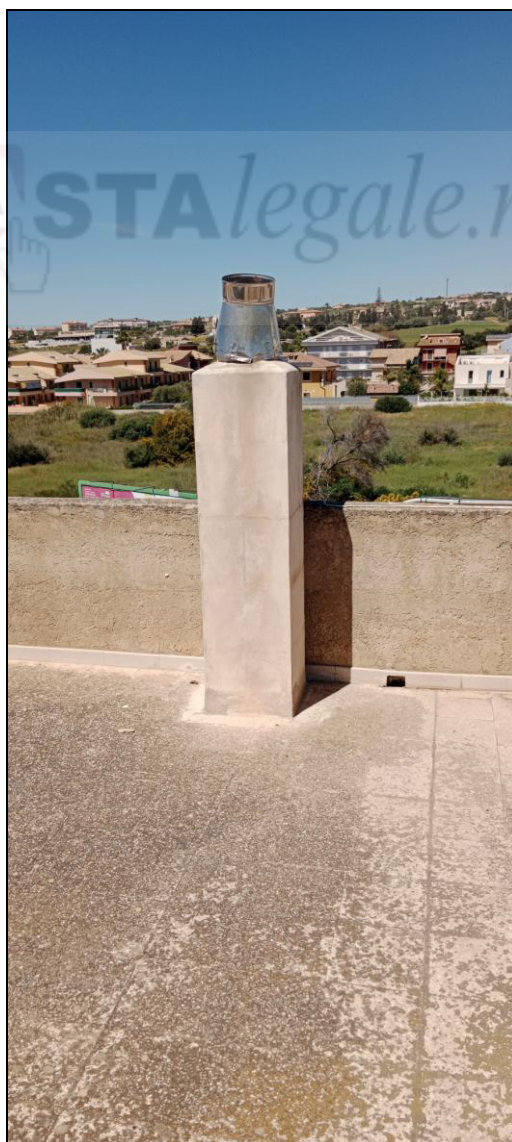
Foto 14 Terrazzo di copertura
