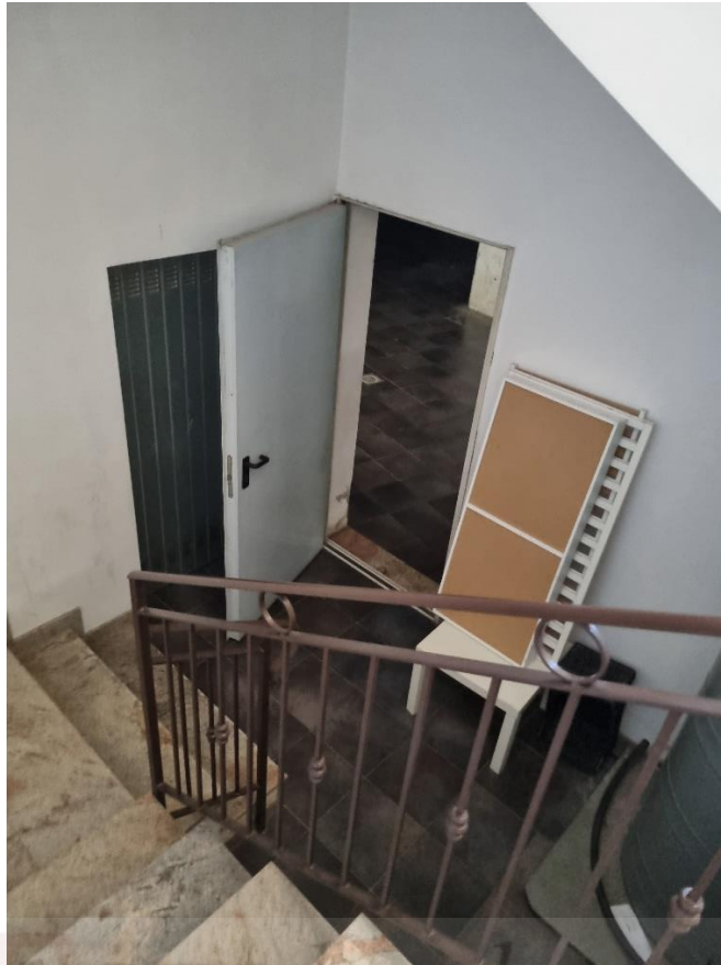
Foto 12– Pota Interna di accesso al Vano gar
