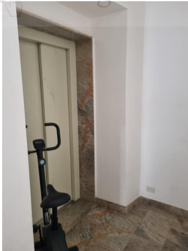
Foto 13– Ascensore Condominiale su vano scala
