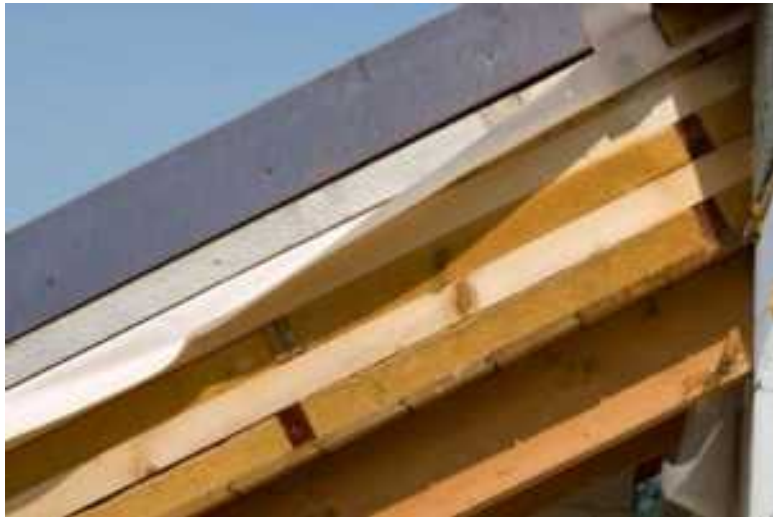
Pacchetto isolante di copertura sp.26cm In fibra di legno
