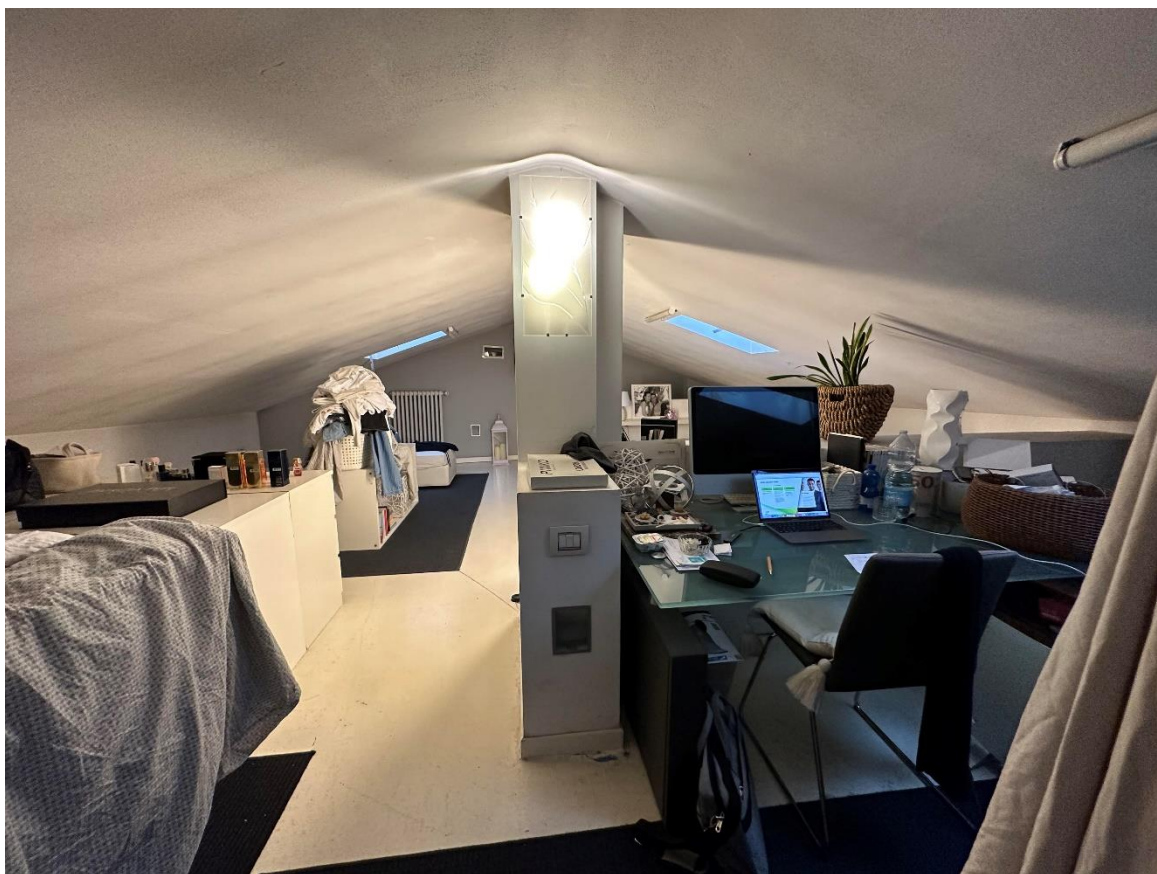
Foto 13. Sottotetto non abitabile
