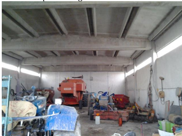
Foto interna capannone agricolo
