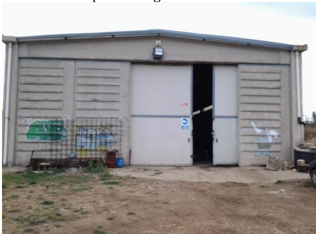
Foto esterna capannone agricolo
