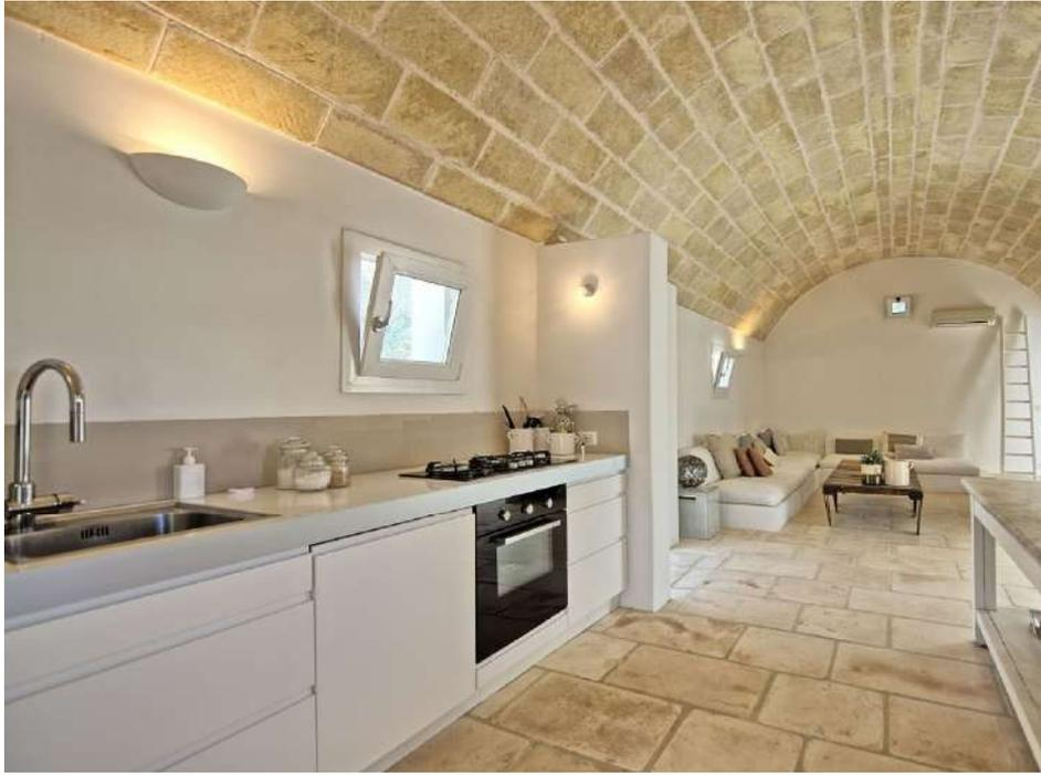
*tipologia di copertura voltata in tufo finita*
