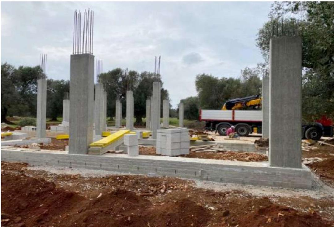
*travi fondazioni e pilastri in cemento armato*
