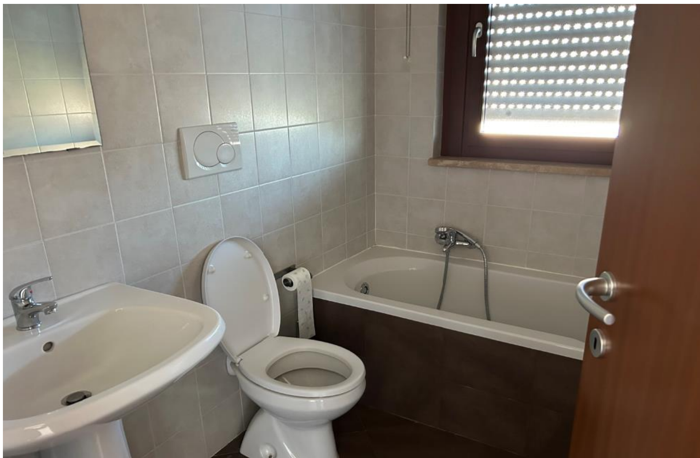
Foglio 669 p.IIa 4906 sub.32 - bagno
