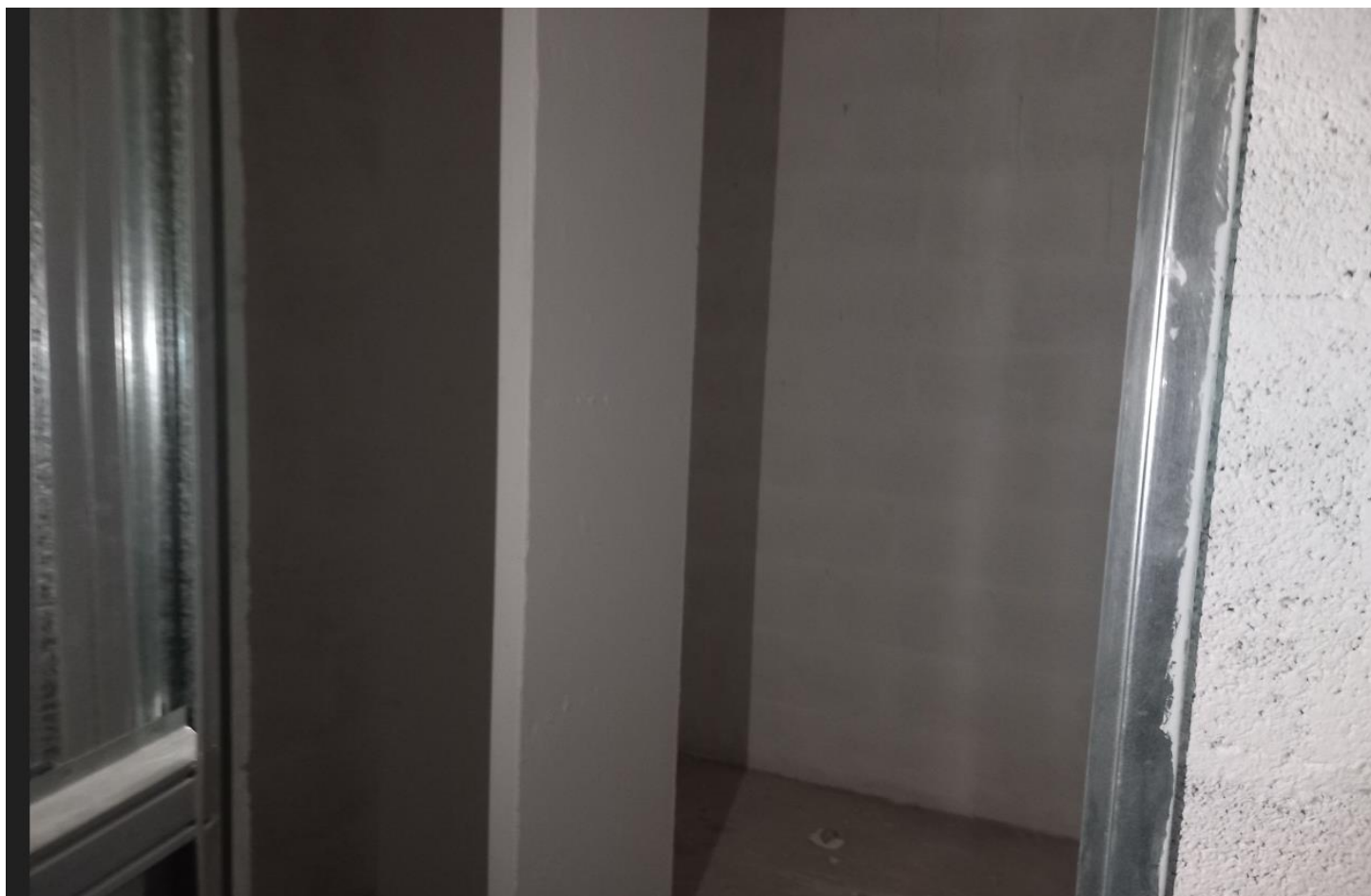
Foglio 669 p.IIa 4906 sub.33 - cantina
