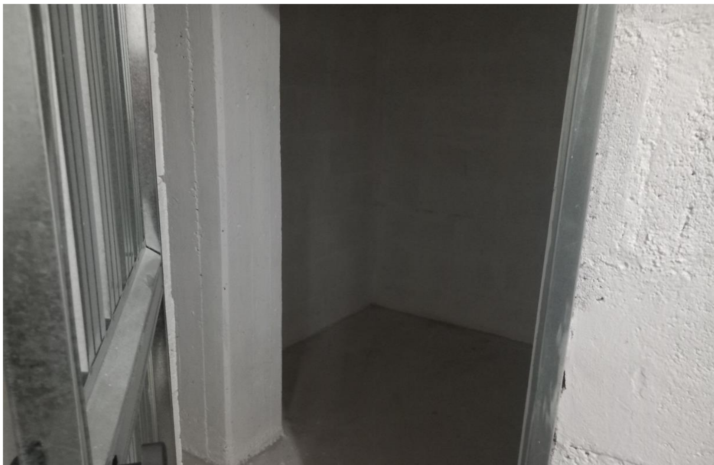
Foglio 669 p.IIa 4906 sub.8 - cantina
