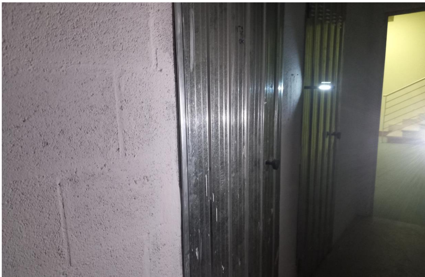
Foglio 669 p.IIa 4906 sub.33 - cantina
