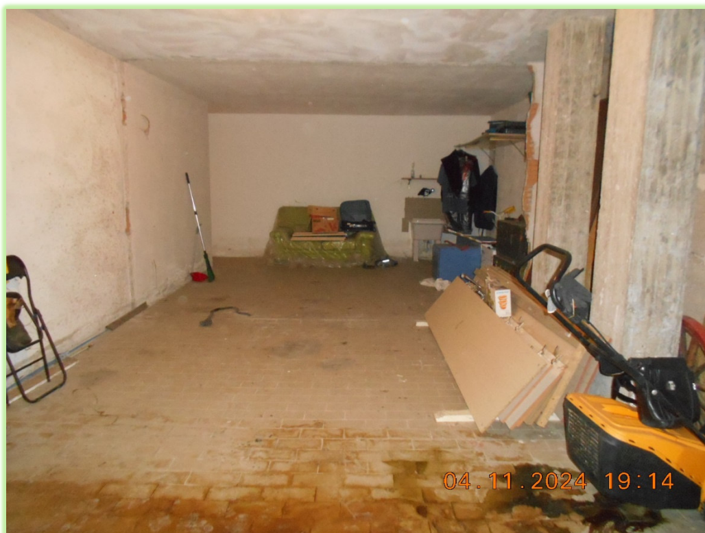
FOTO 10 VISTA DALL'AUTORIMESSA CON MURI DI SEPARAZIONE DEMOLITI
