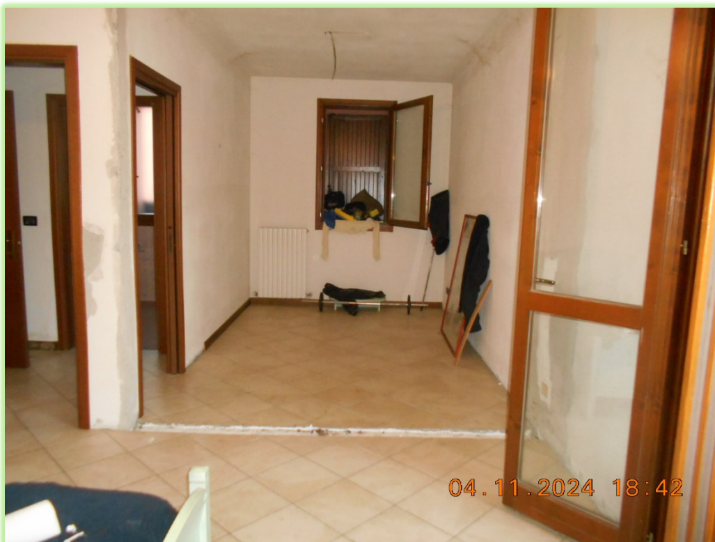
FOTO 08 VISTA CAMERETTA CON MURO DI SEPARAZIONE TRA CAMERE DEMOLITO
