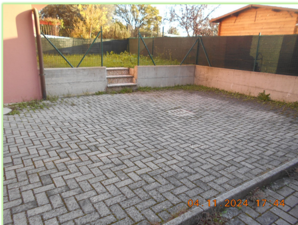
FOTO 11 CORTE ESCLUSIVA PAVIMENTATA
