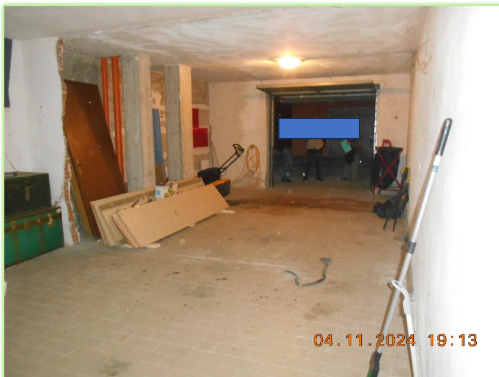
FOTO 09 VISTA DALLA CANTINA CON MURI DI SEPARAZIONE DEMOLITI
