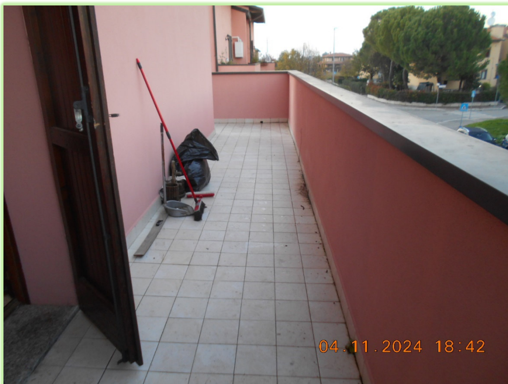
FOTO 04 BALCONE LATO FRONTE STRADA
