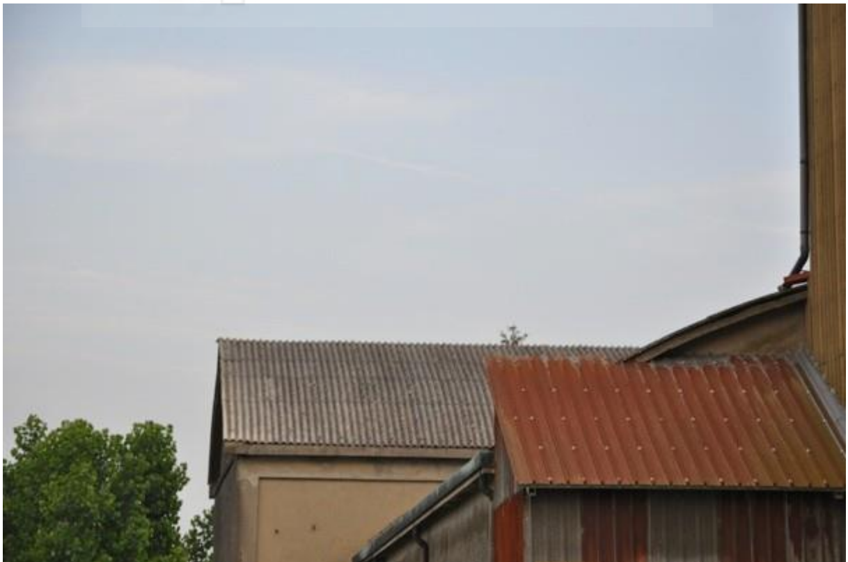
6. Particolare della copertura.
