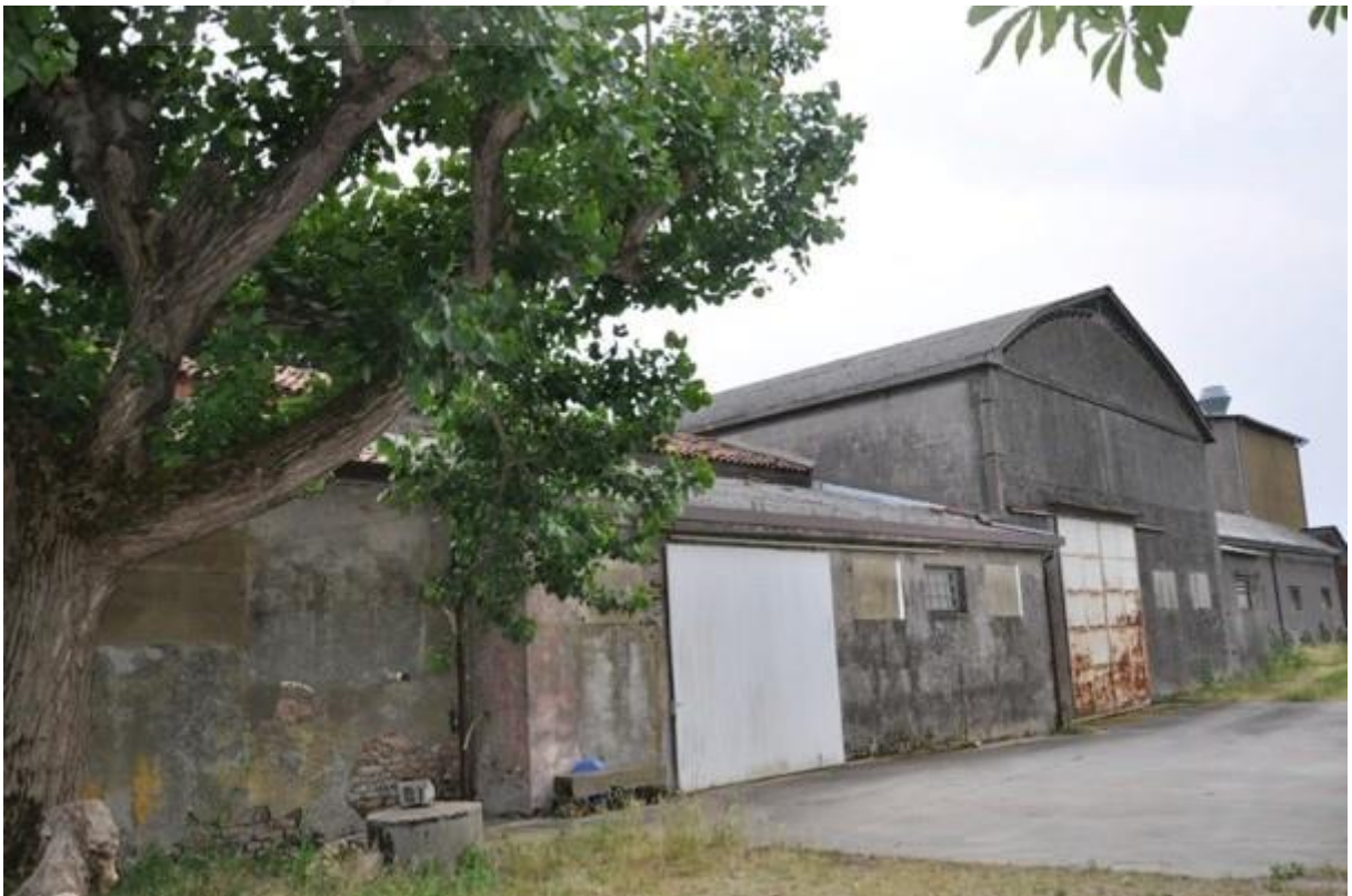
12. Retro della struttura principale.
