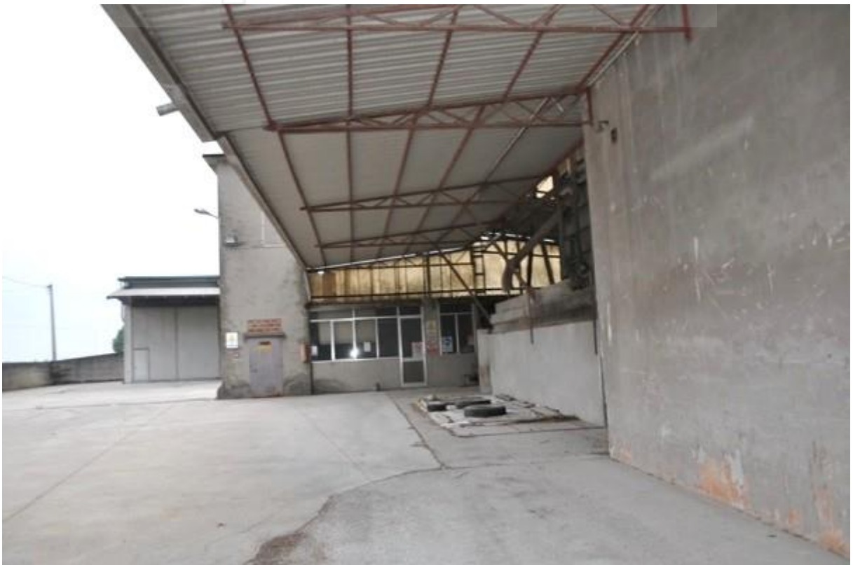
8. Struttura principale --- essiccatoio.
