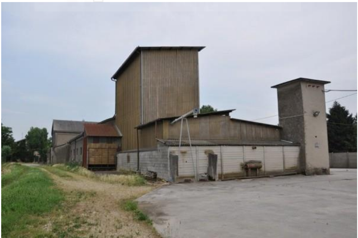
4. Prospetti ovest e nord della struttura principale.
