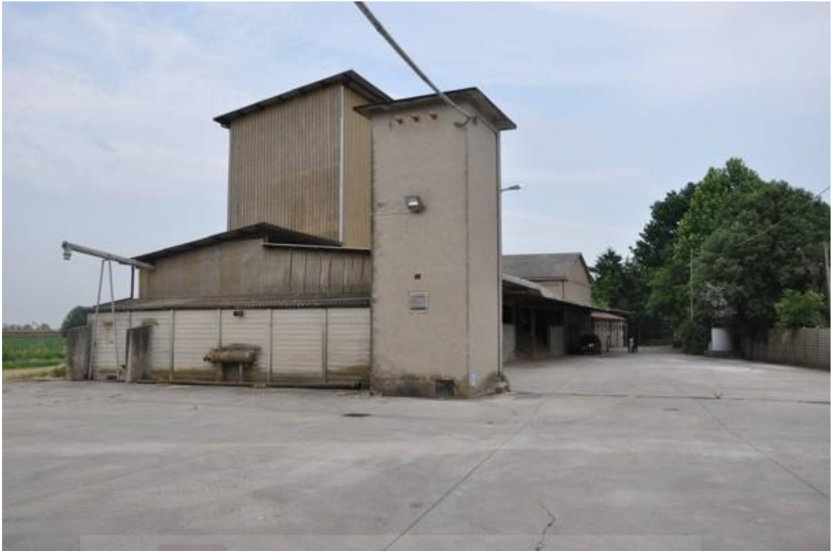
5. Prospetti ovest e sud della struttura principale.
