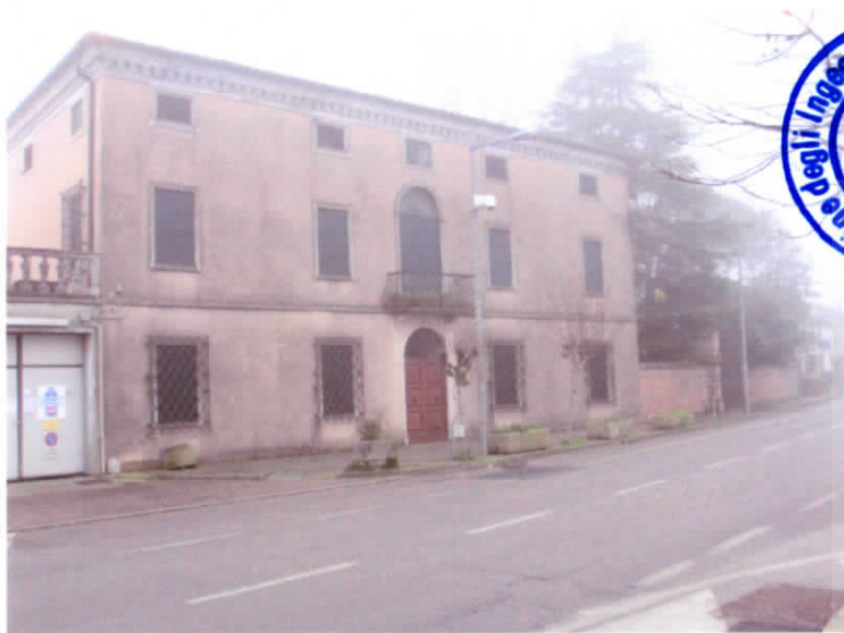
1 – Prospetto NordEst Villa (Via Roma) LOTTO 16
