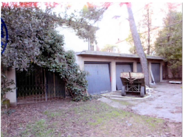
14 – Garage LOTTO 16 e Cancelli NordOvest "Piccolo Brolo"
