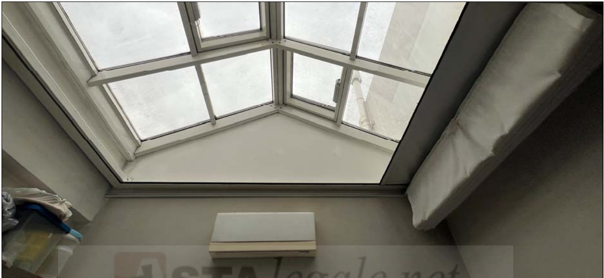
Vista della soprastante copertura in vetro
