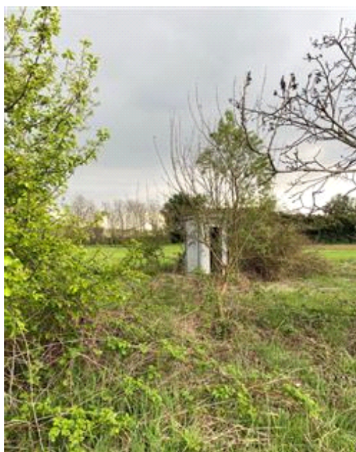
Vista fabbricato in lamiera
