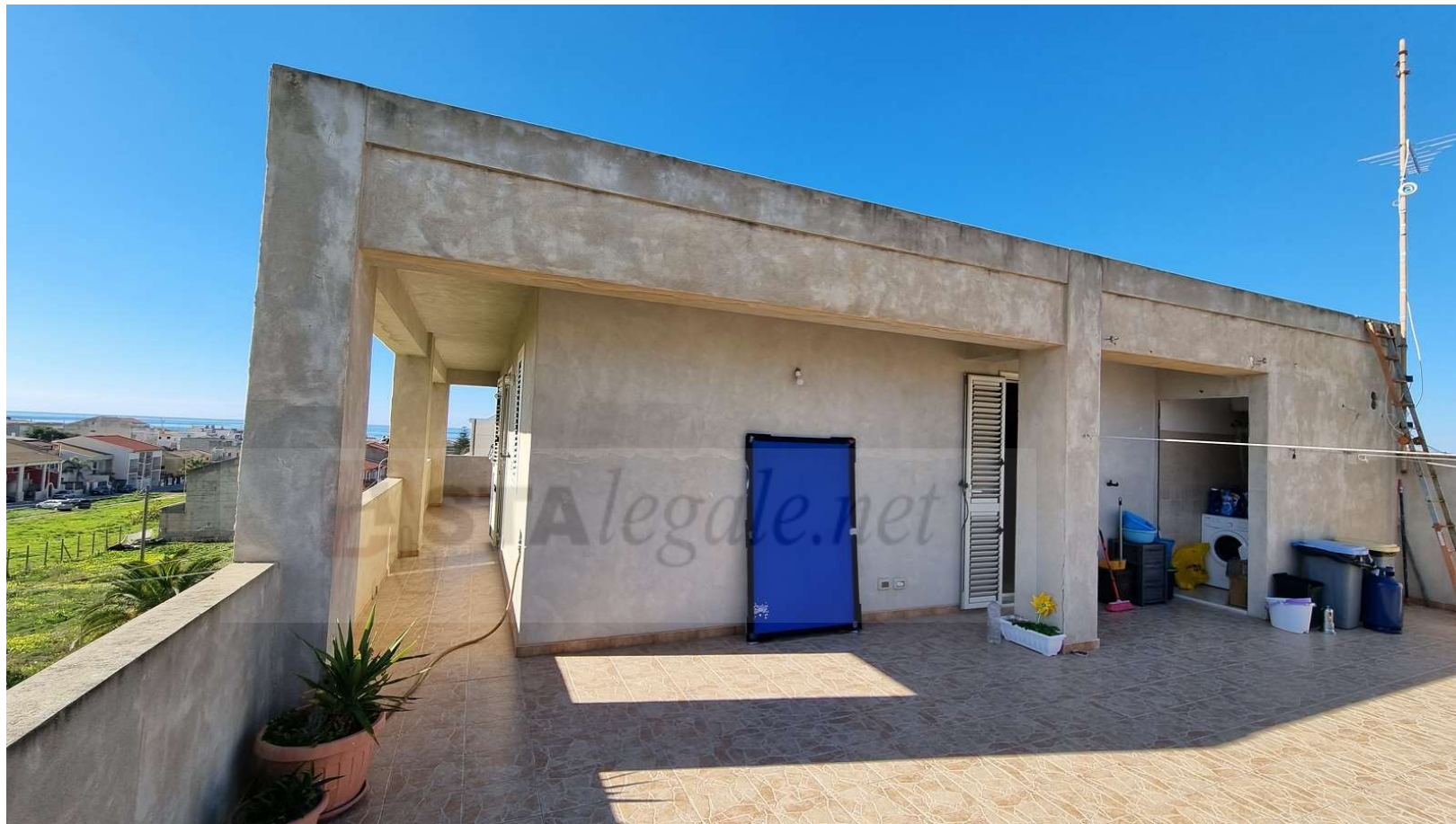
FOTO N. 4 -prospetto est su terrazza
