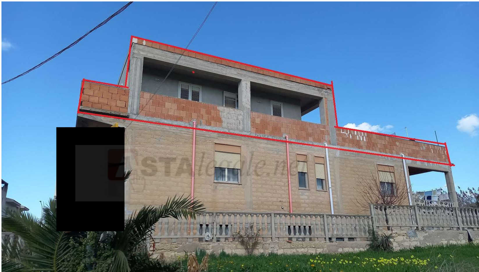
FOTO N. 2 – prospetto sud con indicazione immobile
