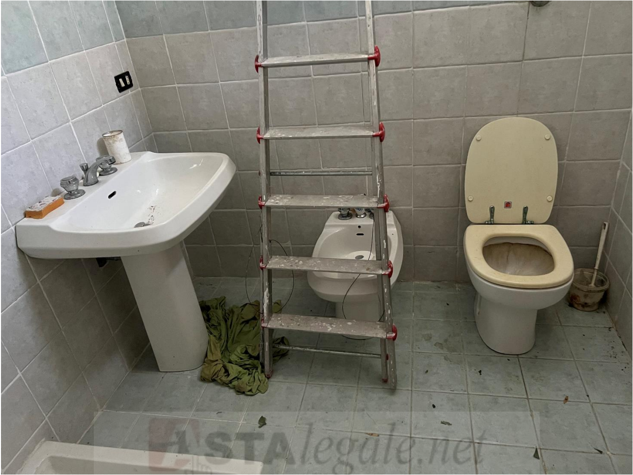
BAGNO NEL GARAGE
