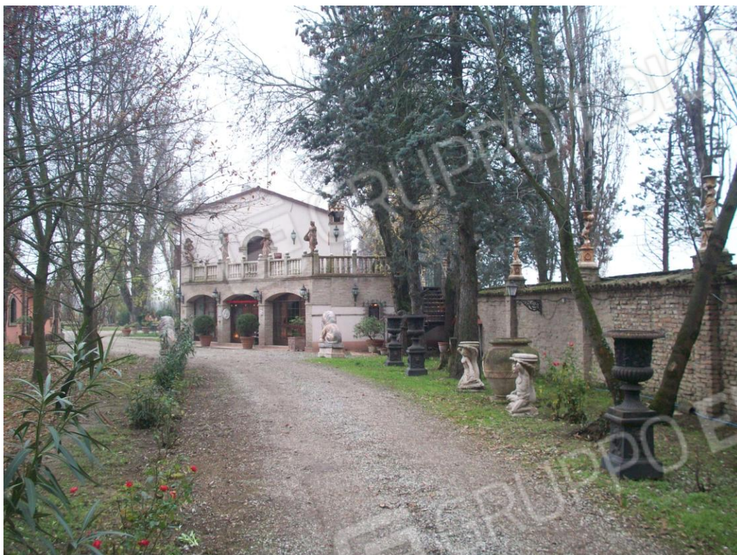
FOTO 7 – PART. FABBR. “B”, MURO DI CINTA, PARCO
