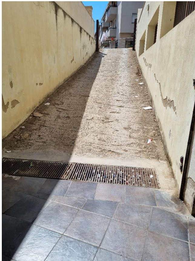
Foto 15– Scivola di condominiale di accesso al Vano Gar
