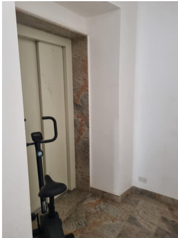
Foto 13– Ascensore Condominiale su vano scala
