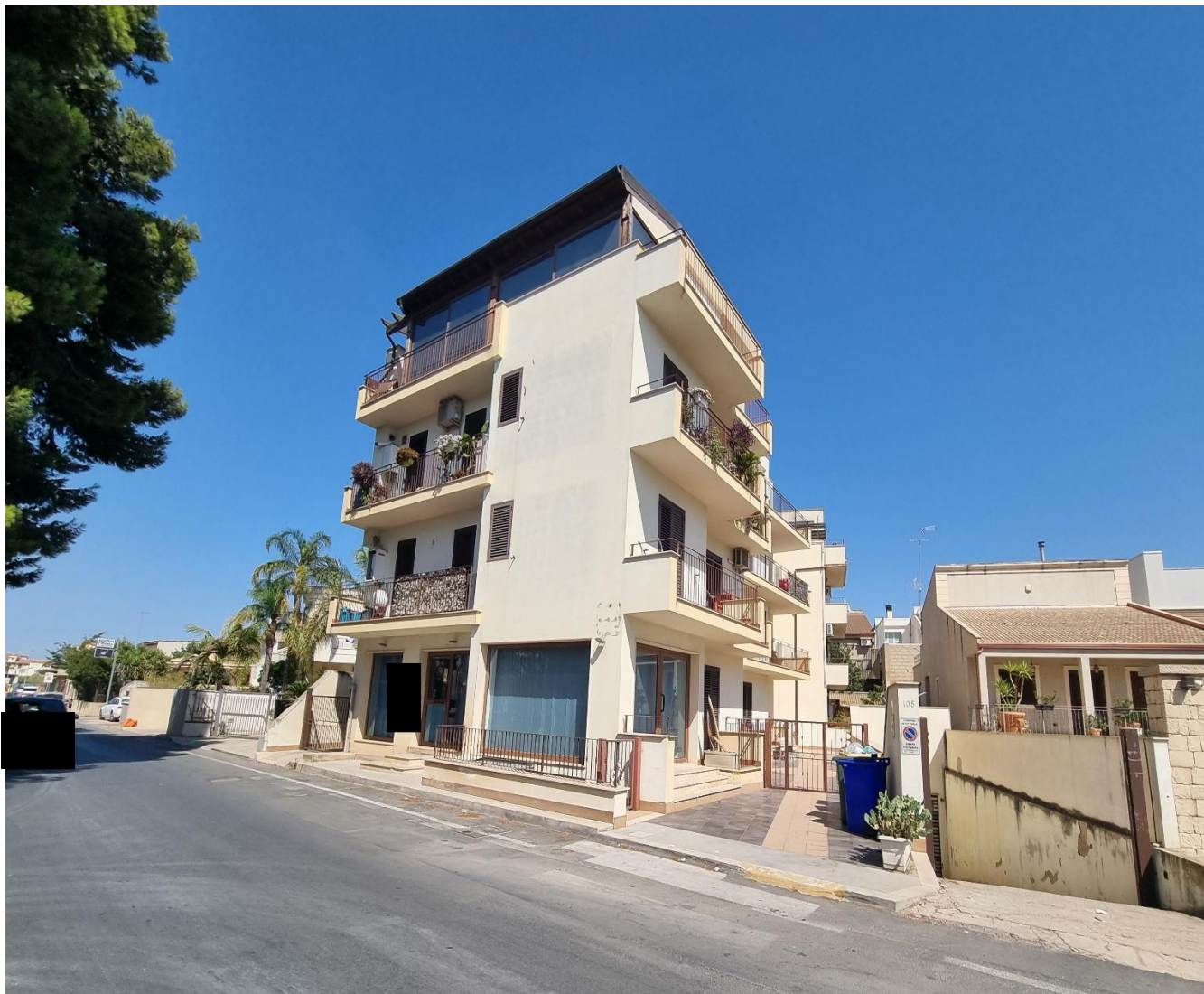
Foto 1 - Accesso condominiale all'immobile da Stradale Vittoria - Scoglitti - [REDACTED]
