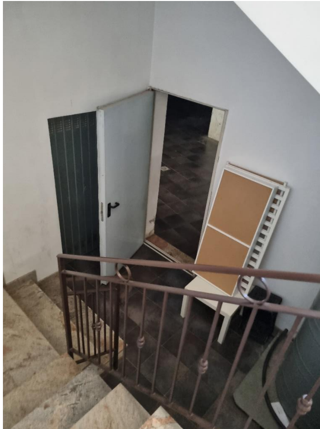
Foto 12– Pota Interna di accesso al Vano gar
