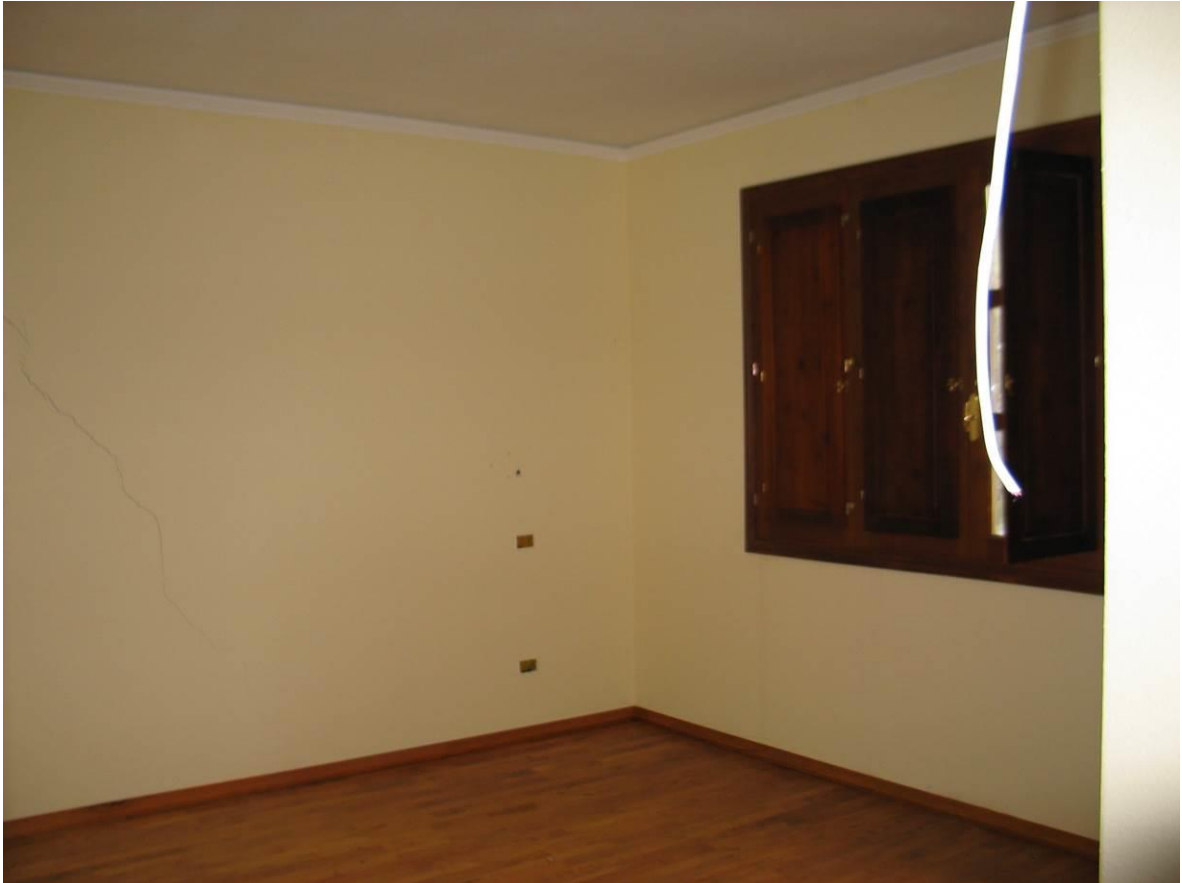
Foto 25 – primo piano - camera
