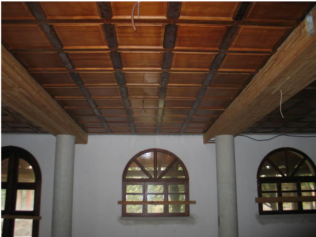
Foto 32 – piano terra – controsoffitto a cassettoni
