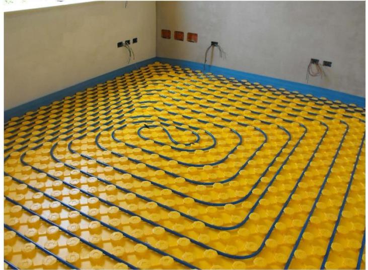
Nelle unità abitative il riscaldamento sarà a pannelli radianti annegati nel pavimento, l'impianto sarà completo di pannello isolante in polistirene espanso sinterizzato a celle chiuse con parte superiore bugnata ricoperta con film plastico per barriera vapore, tubo radiante in polietilene reticolato elettronicamente PE-X con barriera antidiffusione ossigeno.
