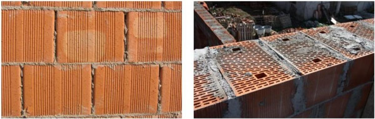
*Fig. 1 – Muratura ordinaria realizzata con blocco POROTON® liscio, con giunto orizzontale e verticale riempito di malta.*
