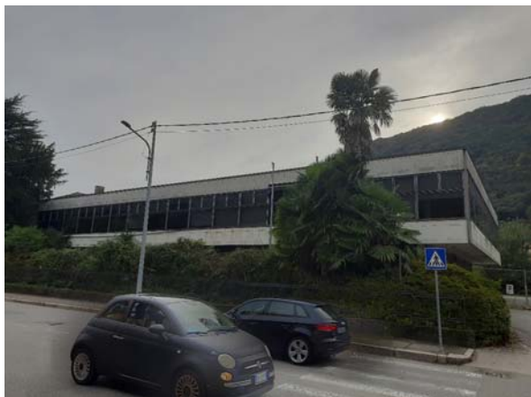
Esterno fabbricato A)
