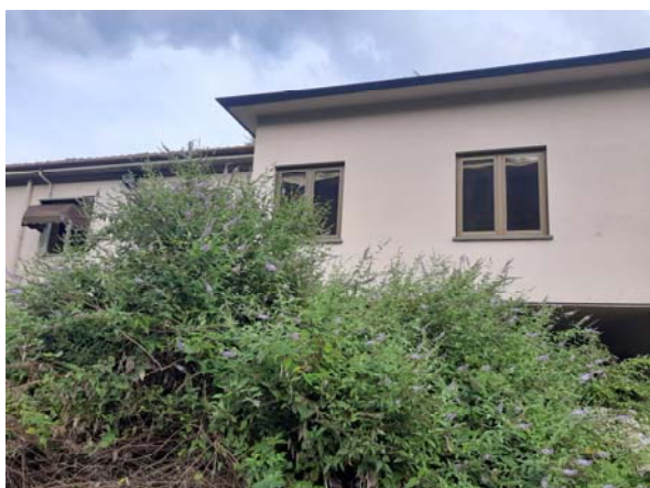
Esterno fabbricato B)
