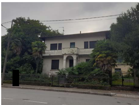
Esterno fabbricato C)
