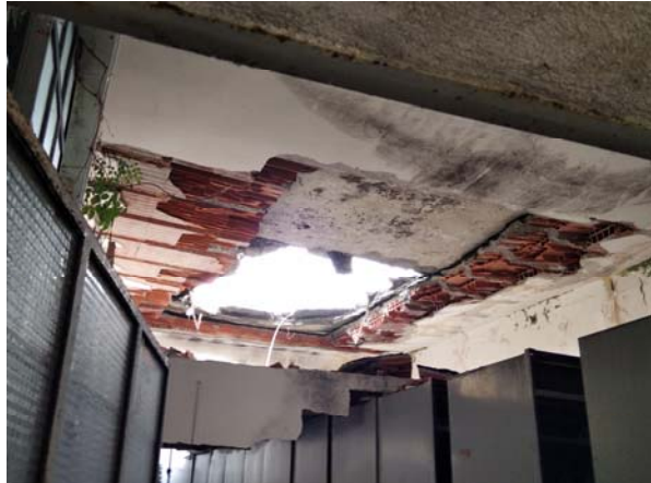
Interno fabbricato D)
