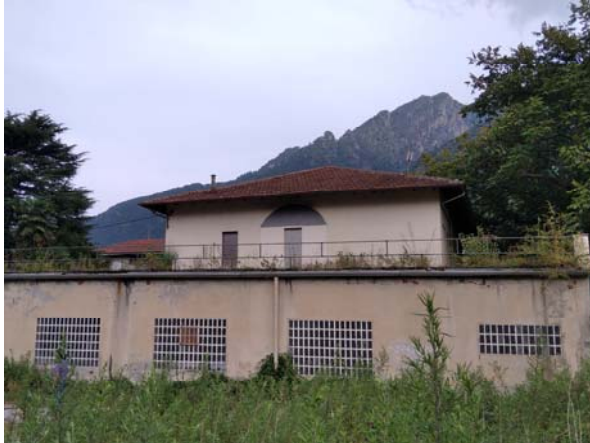
Esterno fabbricato D)
