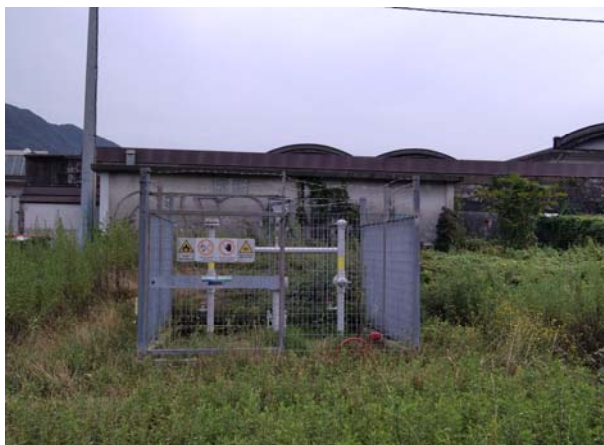
Esterno fabbricato D)
