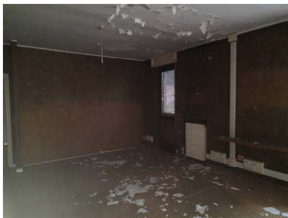
Interno fabbricato C)
