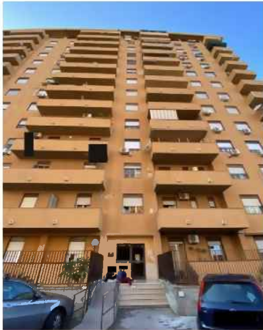
Foto 1. Ingresso immobile Via Pecori Giraldi, n.28, Piano 5, Scala B.
