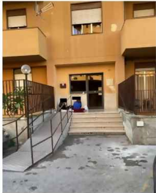
Foto 2. Ingresso immobile Via Pecori Giraldi, n.28, Piano 5, Scala B.
