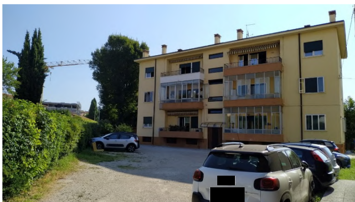
Vista fronte Ovest
