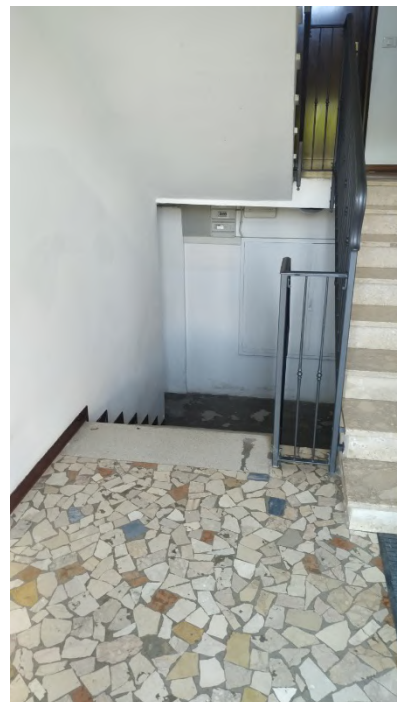
Vista accesso cantine
