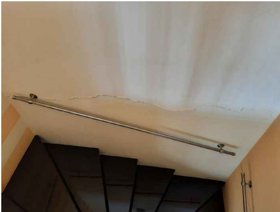
FOTO 15: FESSURAZIONE SCALA
