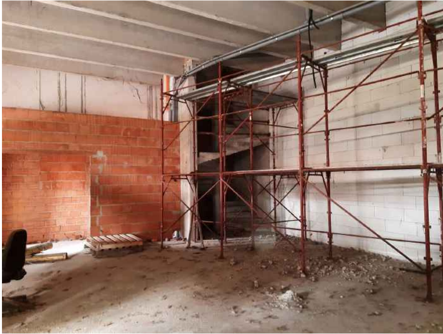
FOTO 23: UNITA' IN CORSO DI COSTRUZIONE
