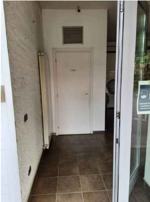
FOTO 21: LOCALE AD USO LAVANDERIA
