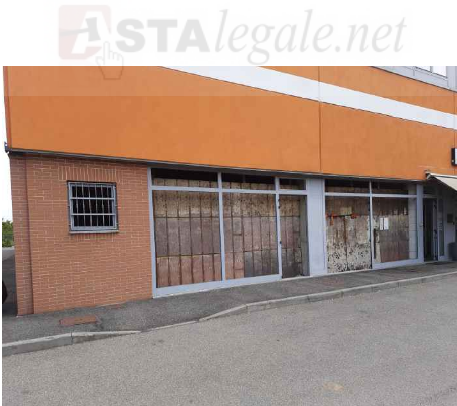
FOTO 24: ESTERNO UNITA' IN CORSO DI COSTRUZIONE
