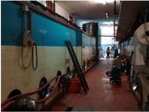
Cantina al piano sottostrada
