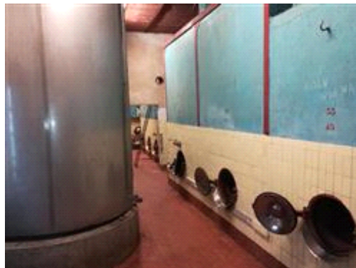
Cantina al piano sottostrada
