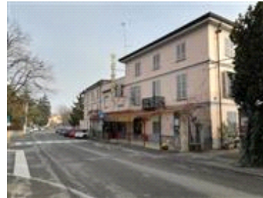
Vista dalla Strada Prov.le
