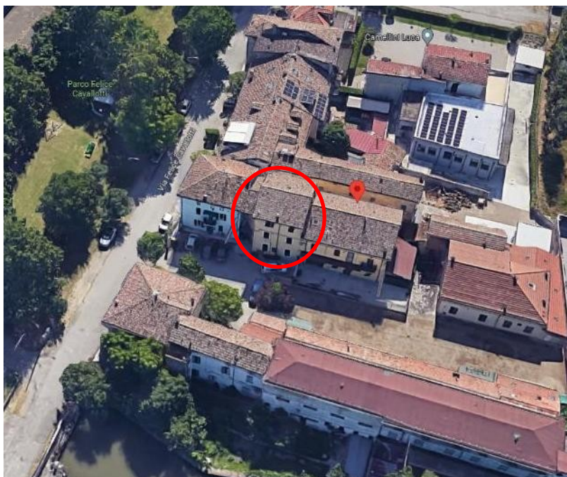
Figura 2: vista aerea con indicazione del fabbricato
