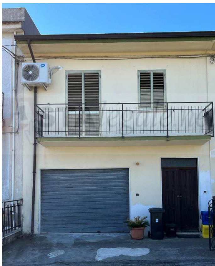
FOTO 13. Prospetto immobile particella 241 foglio 35
