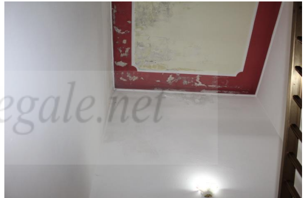
VANO SCALA, PARTICOLARE INFILTRAZIONI D'ACQUA DALLA COPERTURA
