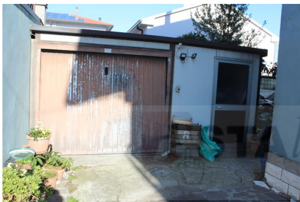
MANUFATTO STACCATO, SULLA CORTE (in parte NON regolare e da demolire)
