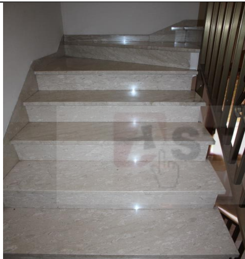
VANO SCALA, PARTICOLARE FINITURA DELLA PAVIMENTAZIONE SCALA
