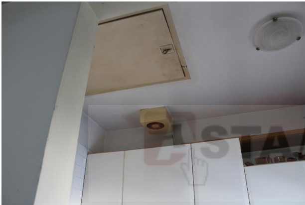
BOTOLA DI ACCESSO AL SOTTOTETTO DALLA CUCINA
