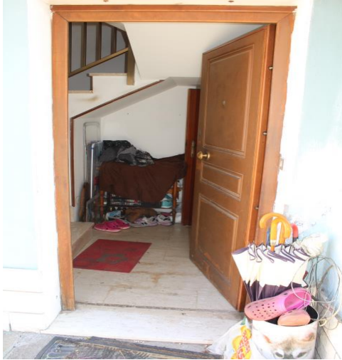
PORTONE INGRESSO AL VANO SCALA DAL PIANO TERRA
