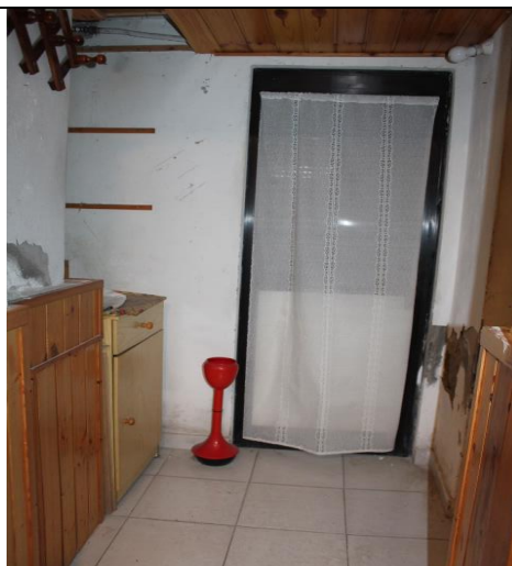
DISIMPEGNO PRIMA DI ACCEDERE AL VANO CALDAIA
