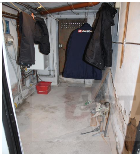
VANO CENTRALE TERMICA
