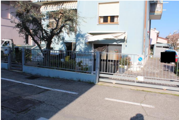
PARTICOLARE DEL CANCELLO CARRABILE CHE NON CONSENTE DI ACCEDERE CON L'AUTO NELL'AUTORIMESSA DEL LOTTO 2
