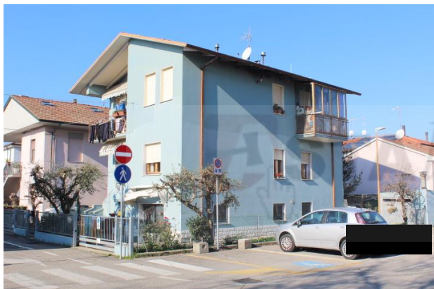
FABBRICATO VISTA ANGOLO SUD (a sinistra su via Lendinara) e EST (a destra)
