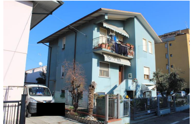
PROSPETTO OVEST (a sinistra) e SUD (a destra) SI NOTA, ALL'ARRIVO SCALA ESTERNA, LA NICCHIA CONTATORI ENEL
