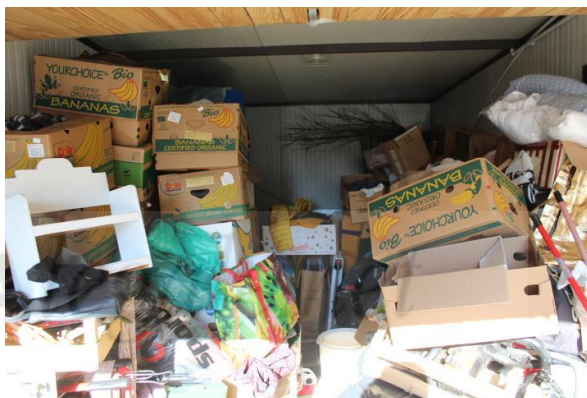
VISTA INTERNO VANO 1 (non regolare ed in parte da demolire)
