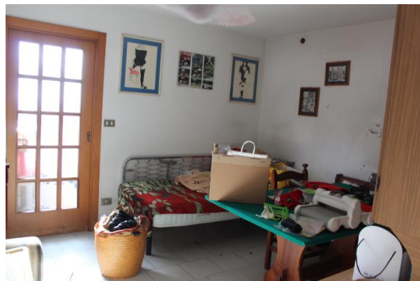
AUTORIMESSA AL SEMINTERRATO. VISTA VERSO LA PARETE NON REGOLARE DA DEMOLIRE
