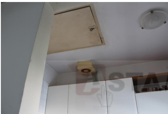
BOTOLA DALLA CUCINA, DI ACCESSO AL SOTTOTETTO
