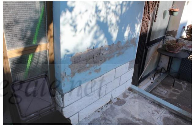
**PARTICOLARE UMIDITA' ASCENDENTE SULLE MURATURE. SI NOTA, DI LATO, LO SCIVOLO PER ACCEDERE AL GARAGE, CHE NON CONSENTE L'ACCESSO AD UNA AUTOVETTURA**
