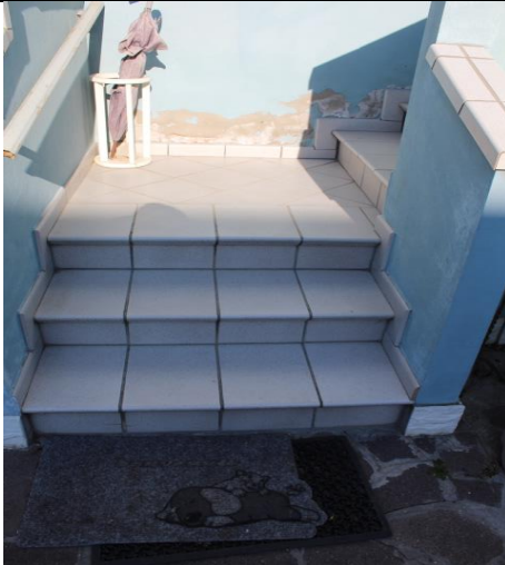
SCALA ESTERNA DI ACCESSO ALL'APPARTAMENTO. SI NOTA L'UMIDITA' ASCENDENTE NELLA MURATURA
