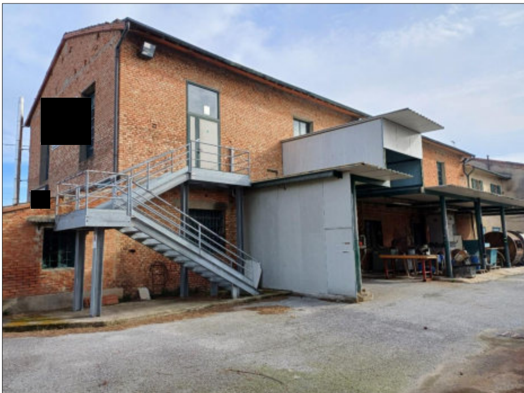
Foto 4 – fabbricato principale – vista anteriore
