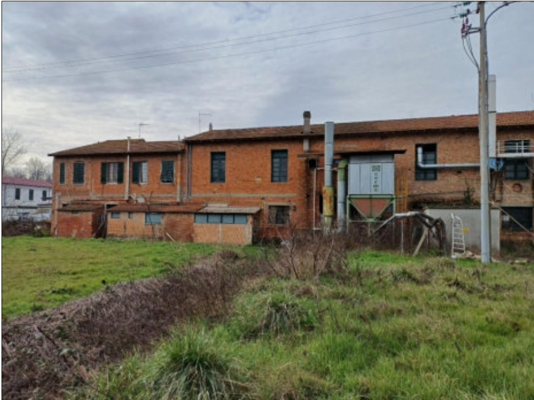
Foto 5 – fabbricato principale – vista posteriore
