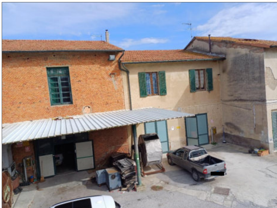
Foto 2 – fabbricato principale – vista anteriore
