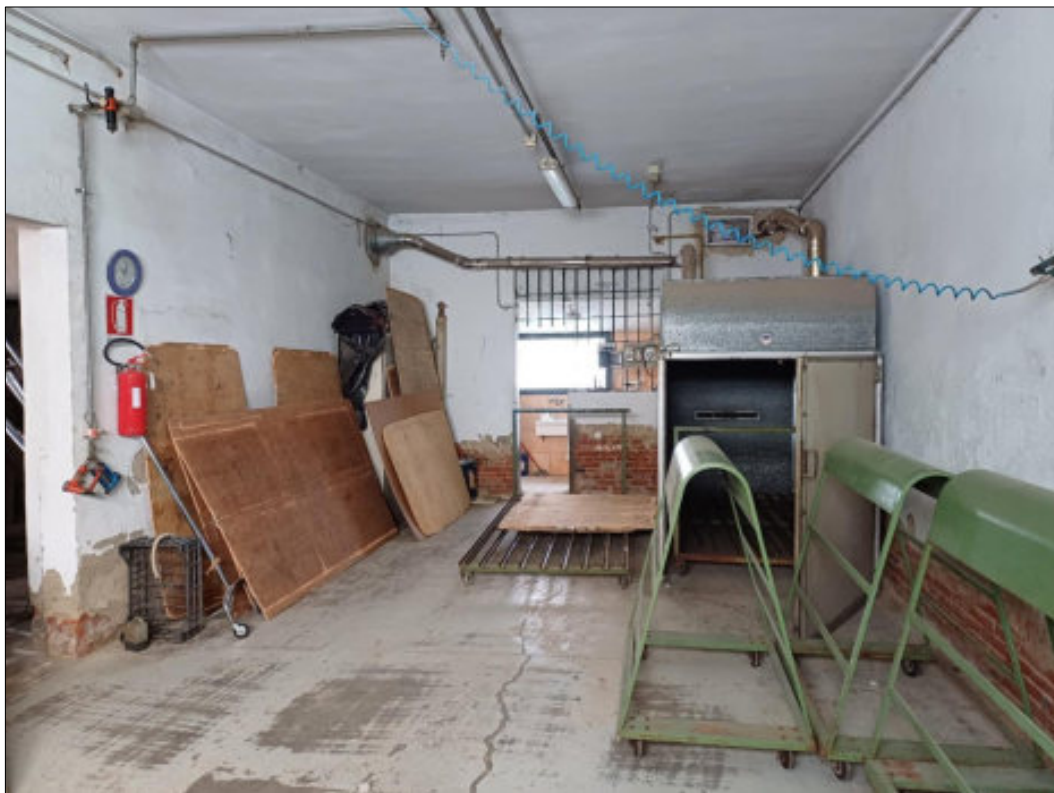
Foto 10 – fabbricato principale - laboratorio
