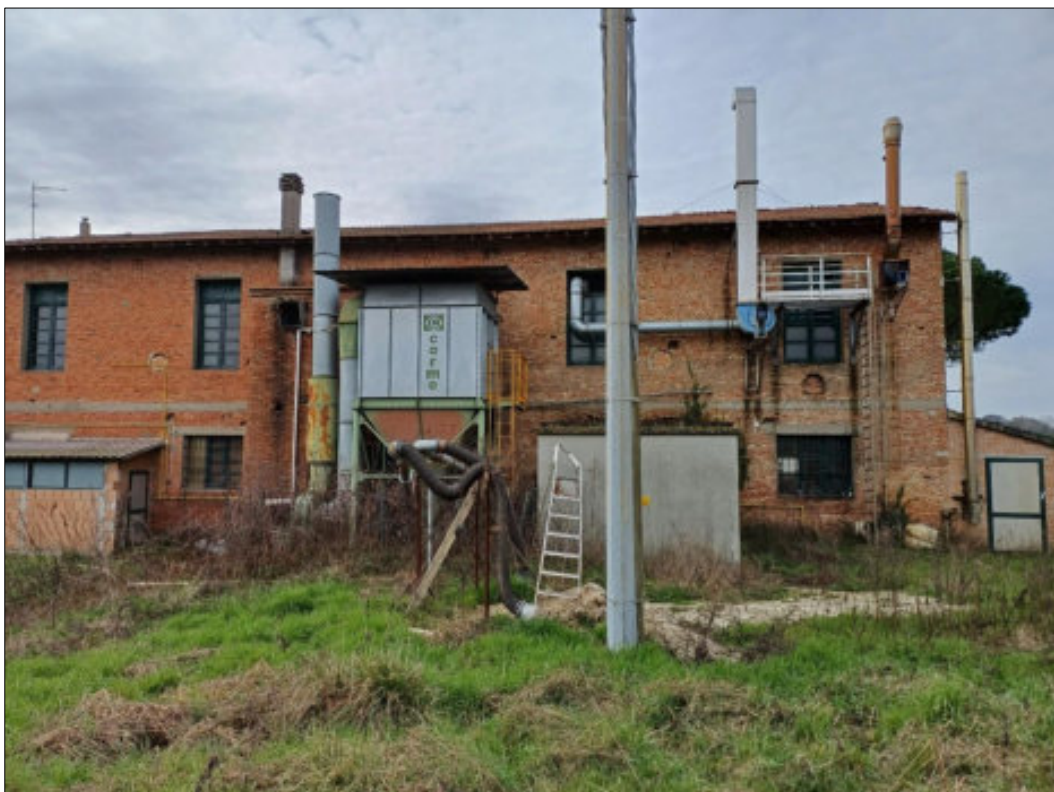
Foto 6 – fabbricato principale – vista posteriore
