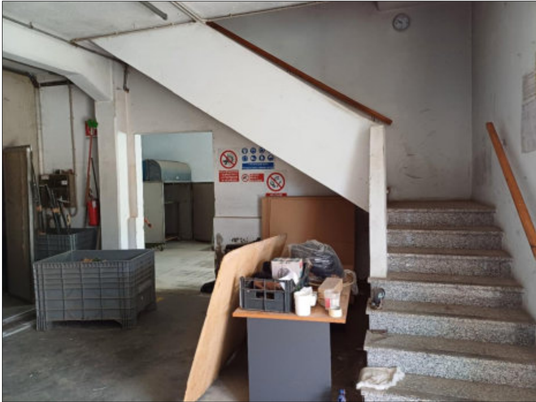
Foto 13 – fabbricato principale – scala collegamento p.t./p.p.
