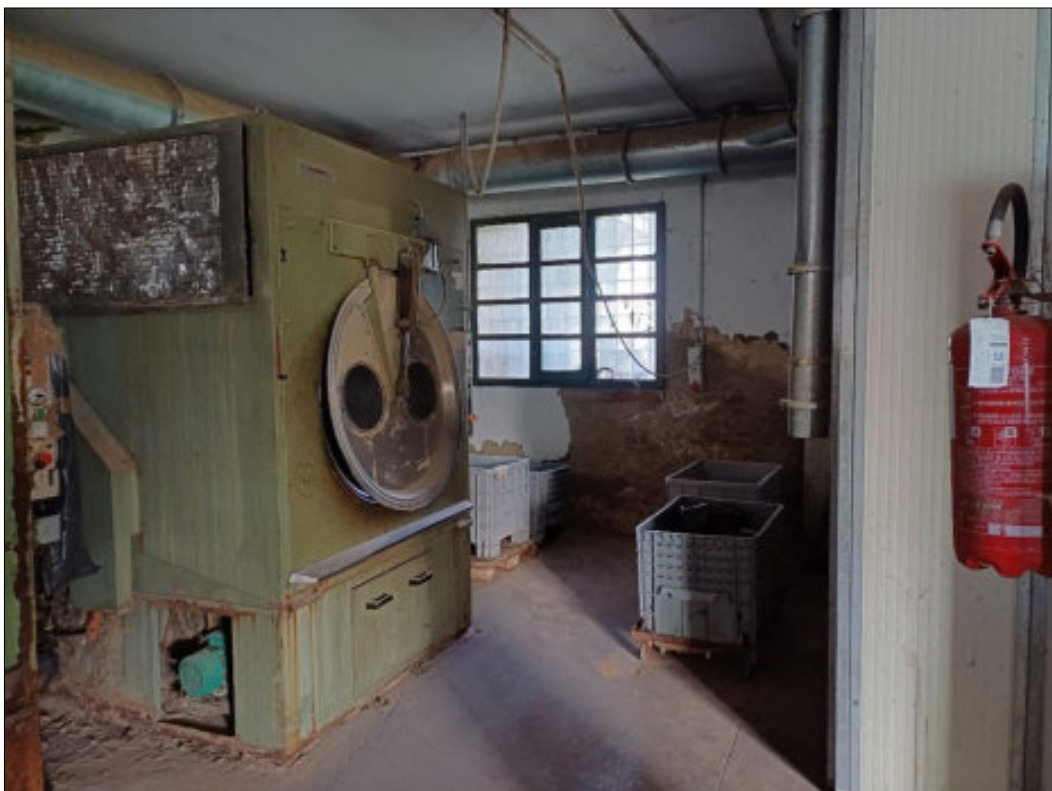
Foto 12 – fabbricato principale - laboratorio
