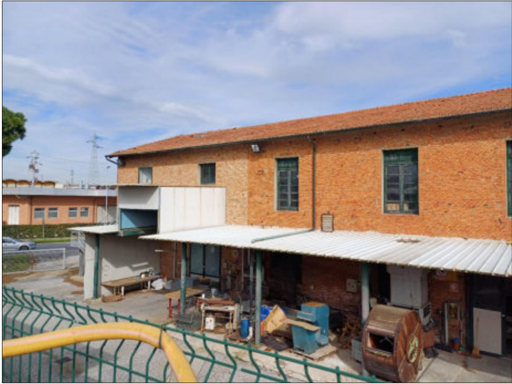
Foto 3 – fabbricato principale – vista anteriore
