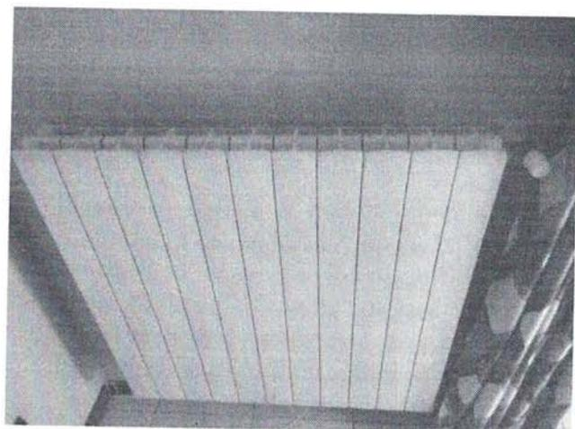
Foto 6) Part. sistema di emissione (radiatore)
