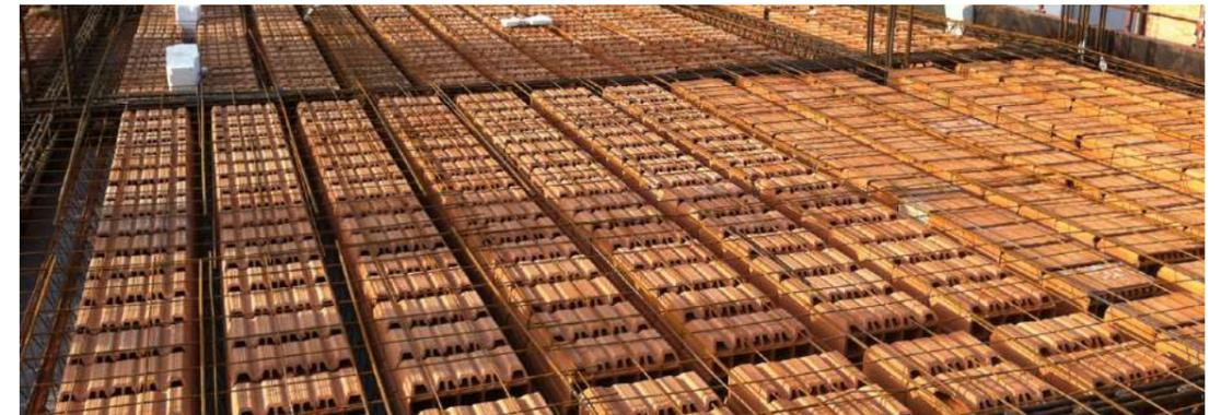
Figura 4 - Solaio laterocemento realizzato in altro cantiere
