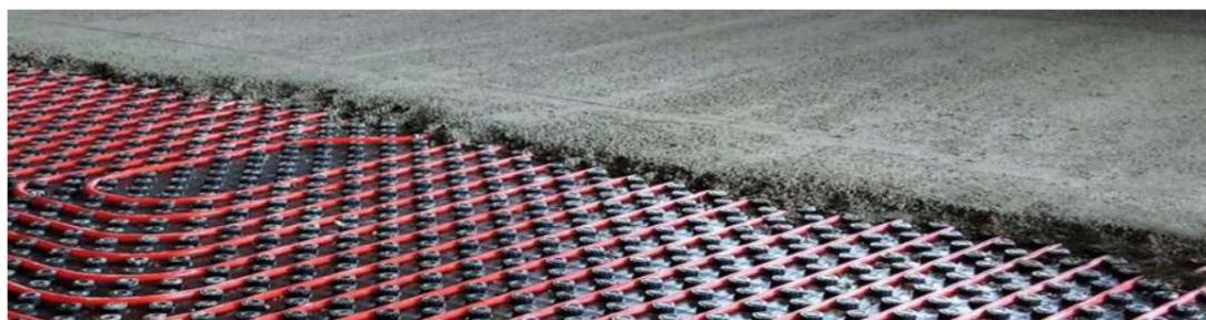
Figura 12 - Massetto radiante
