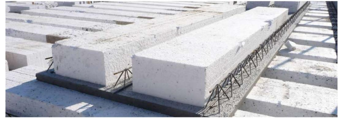
Figura 3 - Solaio tipo in predalles
