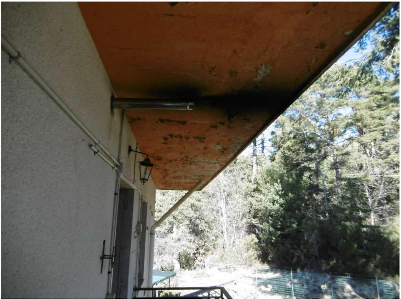
Foto n. 17 scarico stufa a pellet
