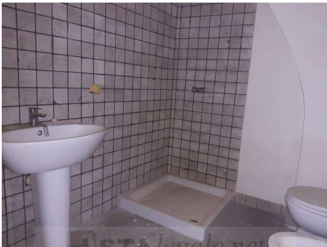
Vista n.13 – Bagno (piano secondo sottostrada) –
