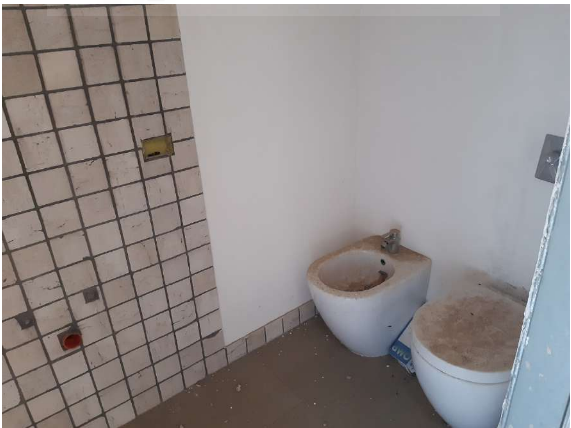
Vista n.8 – W.C. (piano primo) –
