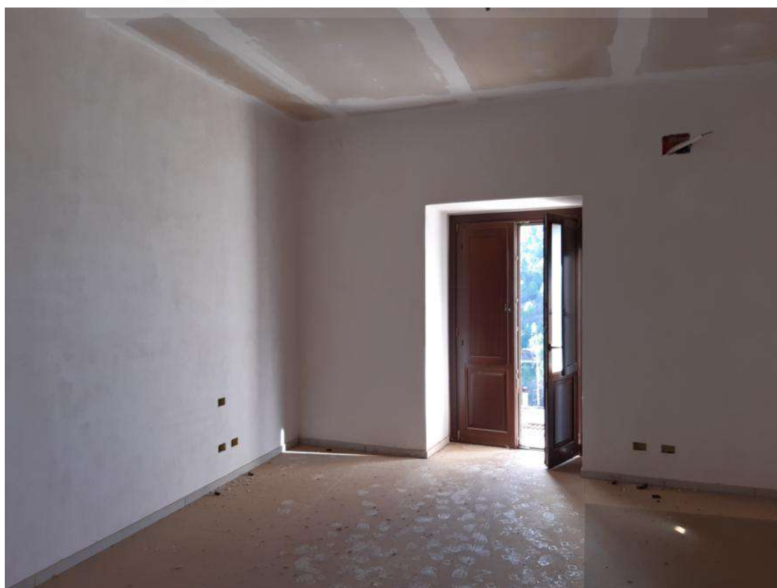
Vista n.10 – letto (piano primo sottostrada) –
