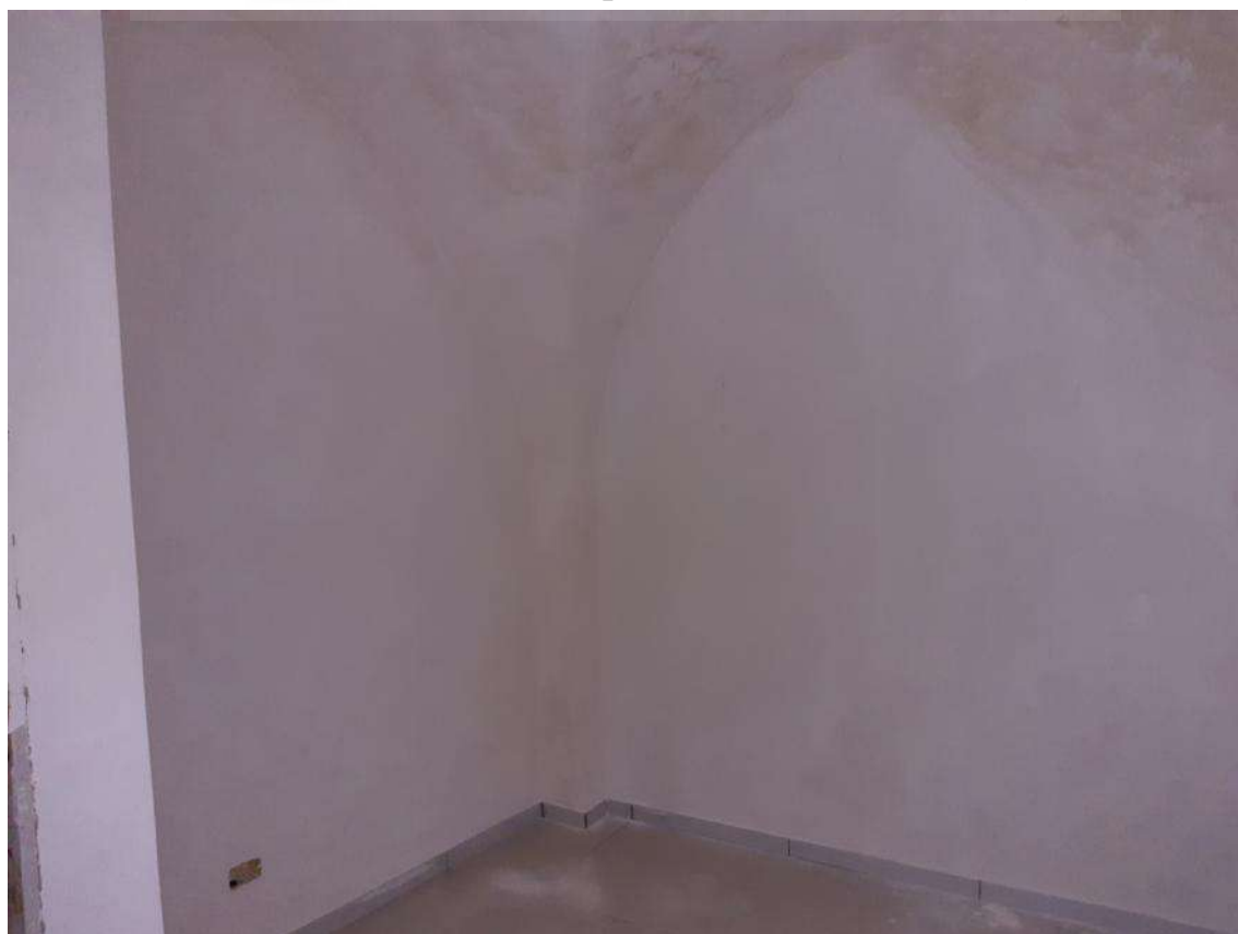
Vista n.14 – Guardaroba (piano secondo sottostrada) –
