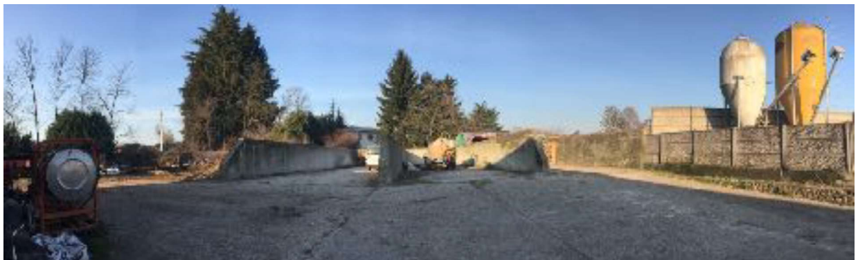
Foto 15- esterni Silos orizzontali aperti
