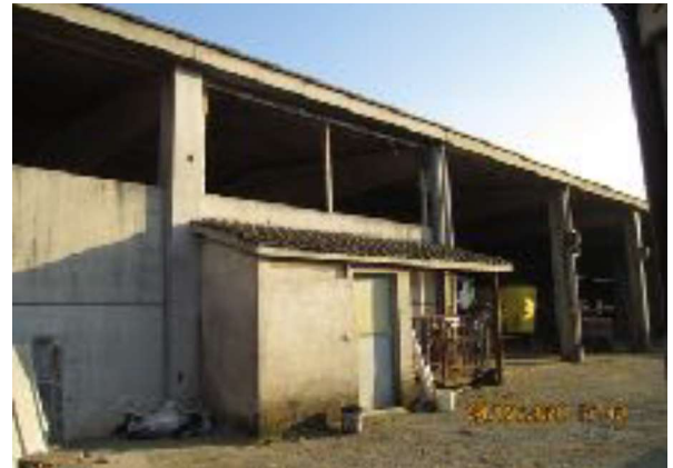
Foto 14- esterni Deposito tettoia
