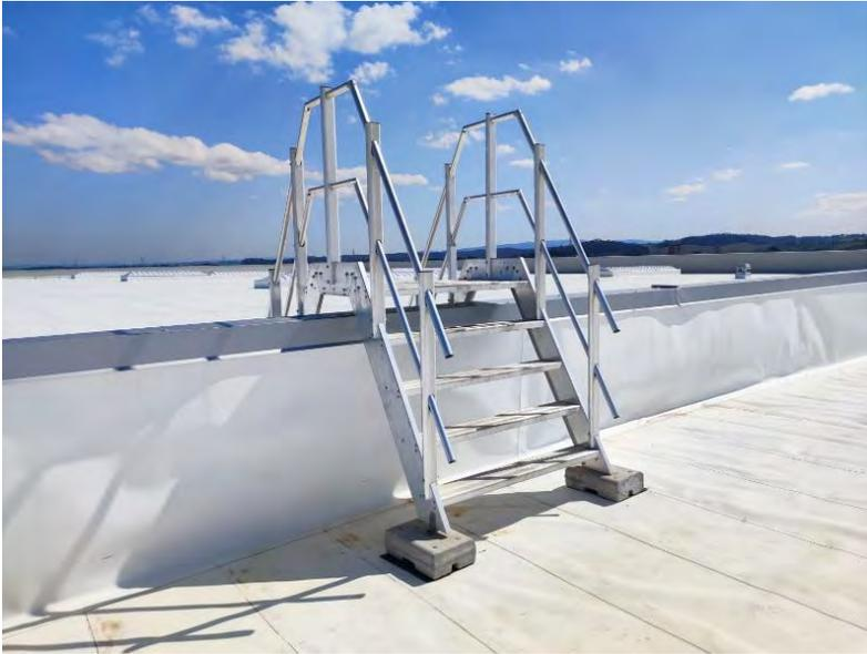
**Figura 64 – Scaletta metallica Copertura**
