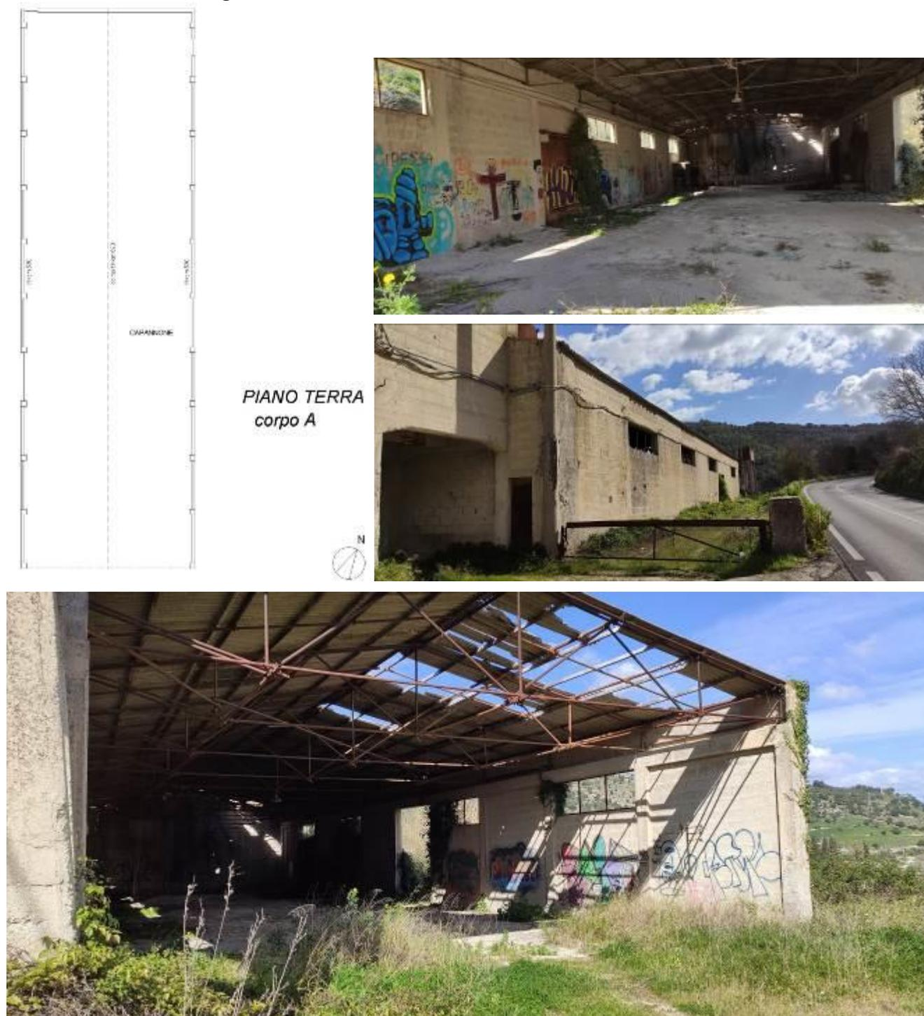
Il lato minore di sud-est del capannone è completamente aperto e limitrofo ad un serbatoio fuoriterra in ferro sostenuto da quattro pilastri in cls armato mentre l'altro lato minore, quello di nord-ovest,
