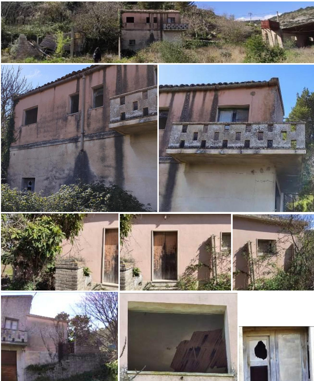
Come si evince dalle immagini riportate l'intero corpo versa in stato di abbandono, probabilmente sono presenti delle infiltrazioni dal tetto di copertura che di riflesso hanno danneggiato il controsoffitto in canna e gesso; gli infissi sono in buona parte assenti o danneggiati. Strutturalmente l'immobile non si presenta in cattivo stato, non sono visibili importanti segni di cedimenti del terreno
